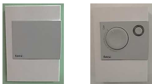
Figure 2-23. Capteurs de GTC
