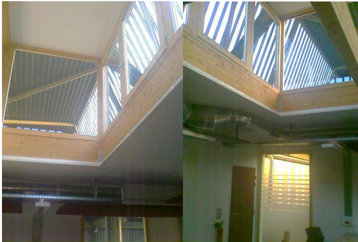
Figure 2-7. Plafond de la salle informatique (Shed)
