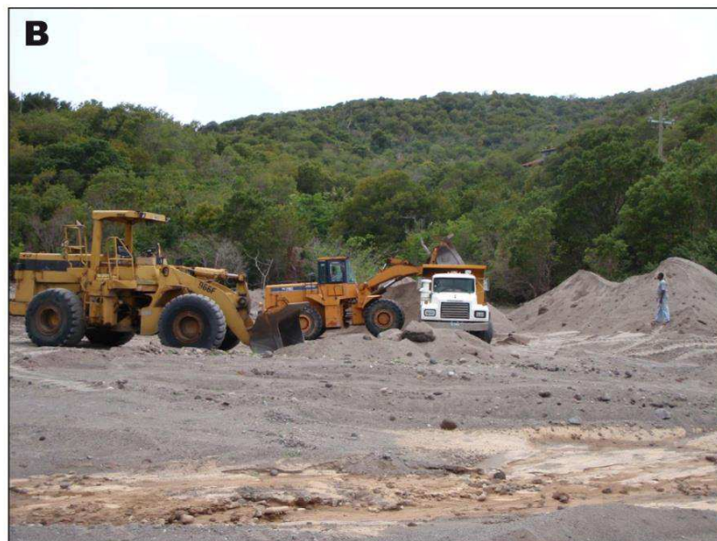
Figure 167 – Corridor de lahars et extraction des dépôts volcanoclastiques à Montserrat. A : Le corridor de lahars de la Belham, à l'ouest de Montserrat (cliché H. Odbert, 2011). B : techniques d'extraction par tractopelles, lesquelles ne sont pas utilisées au Merapi (cliché M. Froude, 2011).
