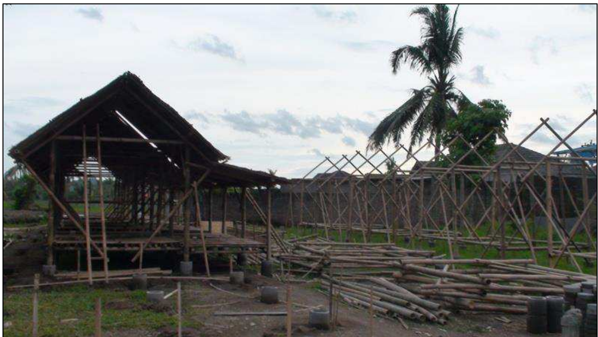
Figure 79 - Construction de nouveaux logements pour les sinistrés du lahar du 30 mars 2011 à Tamanagung, rivière Pabelan (cliché E. de Bélizal, avril 2011)
