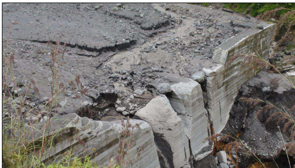
Figure 70 - Le sabo-dam le plus en amont de la rivière Apu, entièrement comblé par les dépôts de lahars de 2010-2011. Situé à 6 km du cratère, construit en 2010, il n'aura été en service que quelques mois à peine. Cliché E. de Bélizal, avril 2011.
