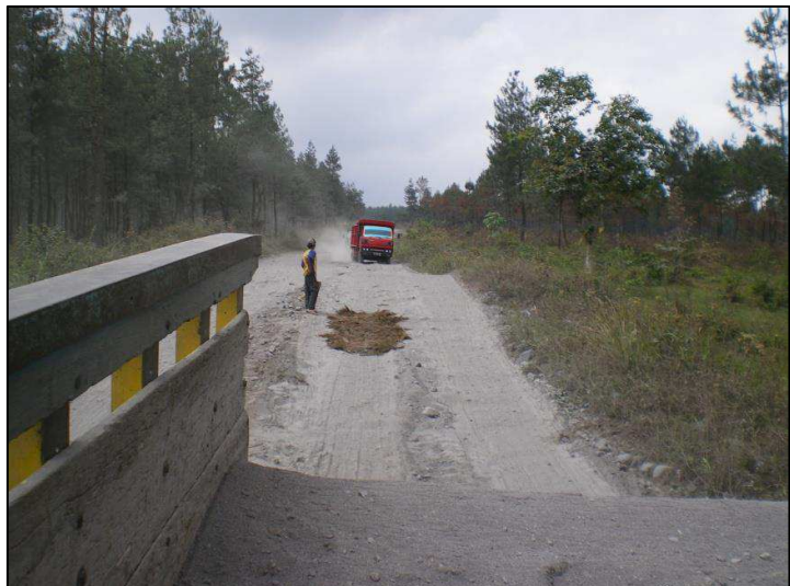
Figure 142 - Un adolescent rebouche les ornières dans l'une des voies d'accès du site de Jurangjero dans la vallée Putih (E. de Bélizal, août 2008)
