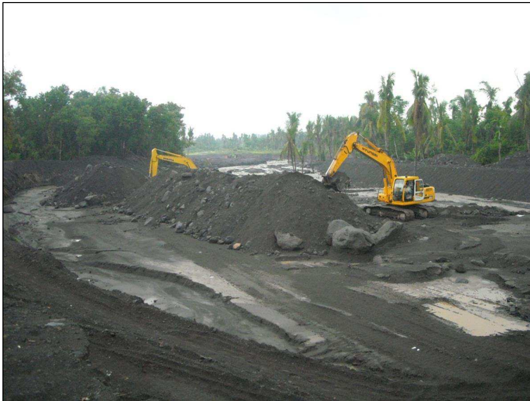
Figure 75 – La lutte contre la sédimentation des rivières sur le talus distal du volcan : incision artificielle des dépôts, création de levées (Putih, 1 km en amont de Jumoyo, cliché E. de Bélizal, mars 2011)
