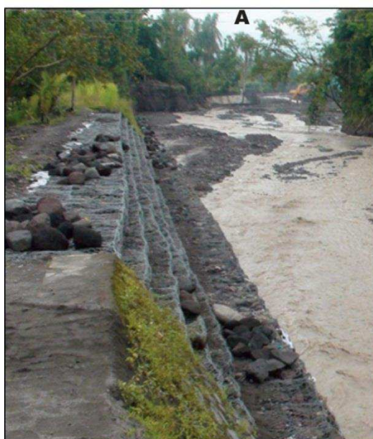
Figure 76 - Enrochements sur les berges de la Putih à 2 km en amont de Jumoyo (A) et (B) bétonnage du chenal sur le talus médial à Srumbung (6 km en amont de Jumoyo) (clichés E. de Bélizal ,A : avril 2011 ; B : mai 2012)
