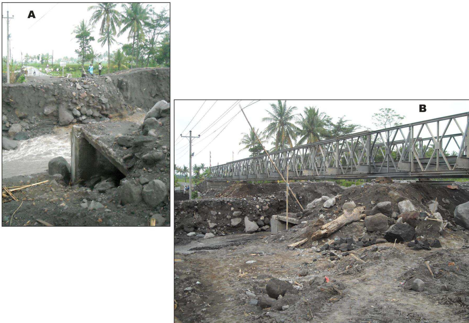
Figure 77 - Un pont temporaire surélevé au-dessus de la Opak à Pangung. Clichés E. de Bélizal, A : les vestiges du pont emporté en janvier 2011 (vu en février 2011). B : le nouveau pont (mars 2011).
