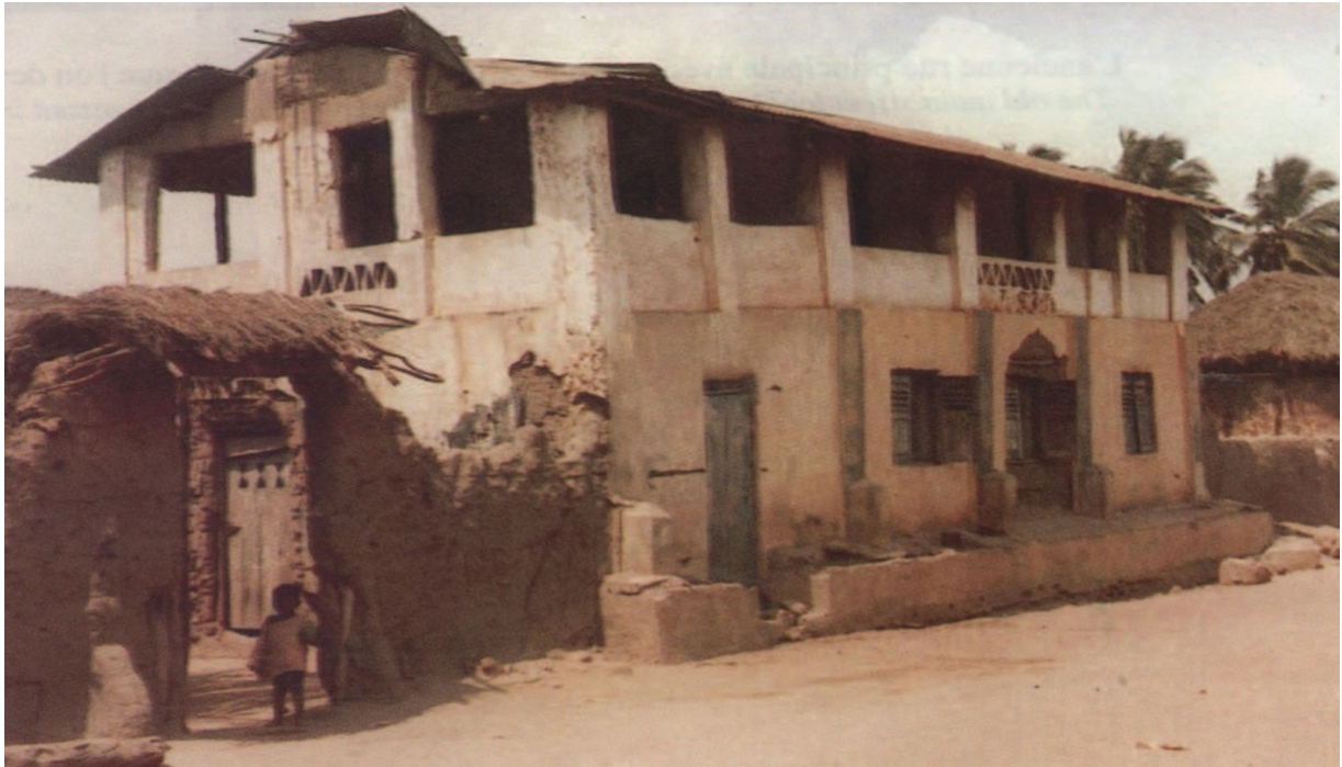
Photographie 75: une maison coloniale au début du XX e siècle (source : Petite anthologie historique de Ouidah)
