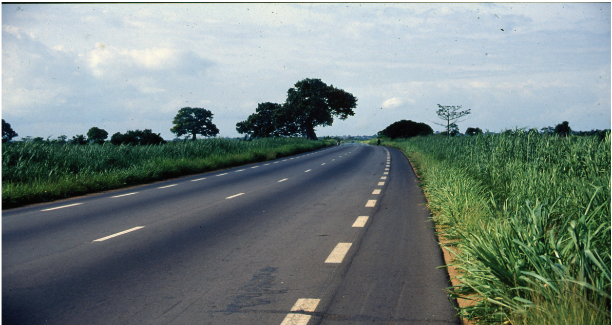
Photographie 94 : Déviation de la RNIE1 : pour éviter l'ensemble d'essences à gauche et à droite sur la photo.
