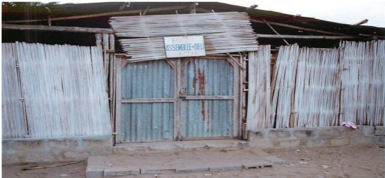
Photographie 21 : Une église d'Assemblée de Dieu dans la banlieue de Cotonou, en matériaux très éphémères
