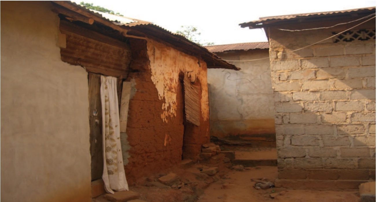
Photographie 59 : À gauche, un mur en terre de barre comme aux origines. À droite, un mur en parpaing style actuel
