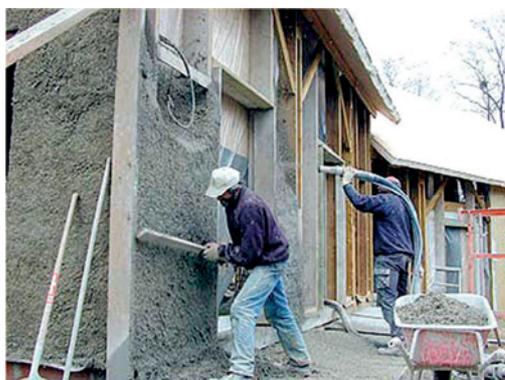
**Figure 1-13** Réalisation d'une paroi par projection<sup>13</sup>
