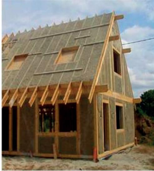
**Figure 1-16** *Habitation en béton de chanvre à ossature en bois*
