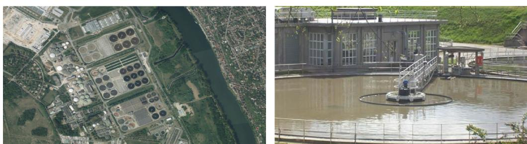
FIGURE 10 – De gauche à droite : Vue aérienne de la station d'épuration d'Achères près de la Seine, à 40 km en aval de Paris (Photo aérienne, IGN 2011), bassin d'oxygénéation de la station d'Achères favorisant la nitrification (Cliché : SIAAP).
