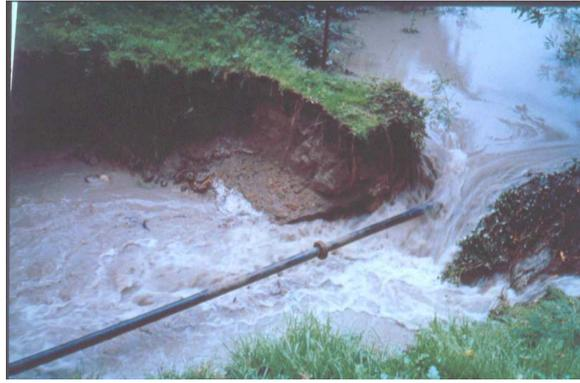
*Figure 5.6. Renard autour d'une canalisation traversant la digue*
