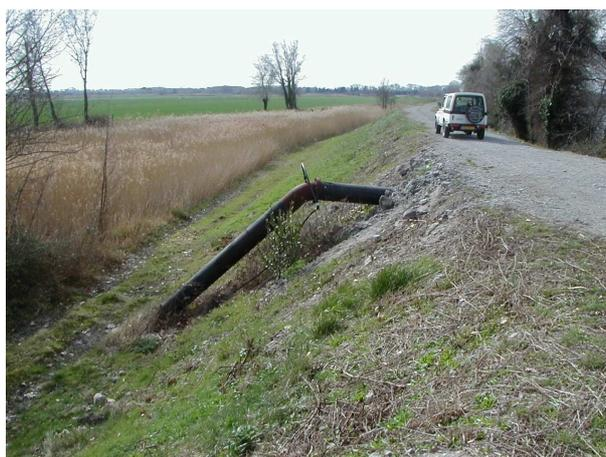
**Figure 2.16. Ouvrage singulier dans la digue : une conduite**
