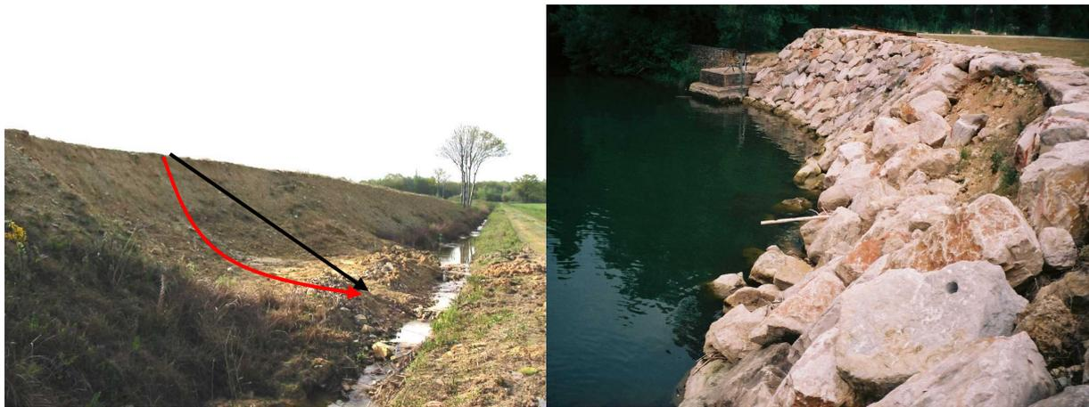
*Figure 5.11. Glissements côté val en crue (photo à gauche) puis côté fleuve à la décrue (photo à droite)*
