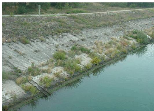
*Figure 2.1. Digue de navigation du Rhône en charge en permanence (Perrier et al., 2004)*
