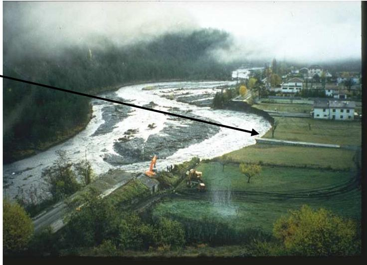
*Figure 5.8. Rupture par érosion externe d'une digue du fleuve côtier Var*
