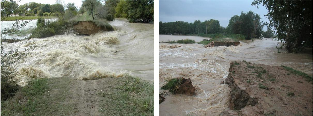
*Figure 5.3. Cas de rupture par surverse sur le Vidourle (Gard)*
