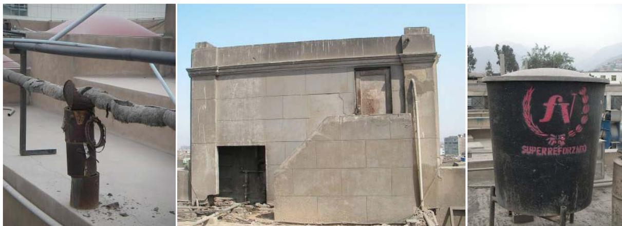
Photos n°53, 54 et 55 : Canalisation soutenues de façon précaire au Sabogal (EsSalud) ; réservoirs d'eau en dur pour le Loyaza et réservoirs plus légers pour le Sergio Bernales (Minsa).
