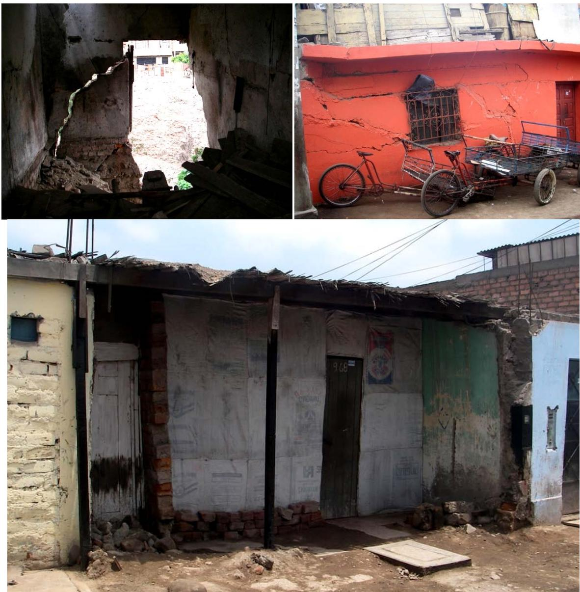
Photos n°21, 22 et 23 : Rive Droite du Río Rímac, maison donnant sur le vide avec la façade effondrée ; maison fissurée construite sur un sol instable dans un secteur d'ancienne décharge ; façade effondrée suite au séisme de 2007 et fermée avec des sacs de jutes en façon temporaire.
