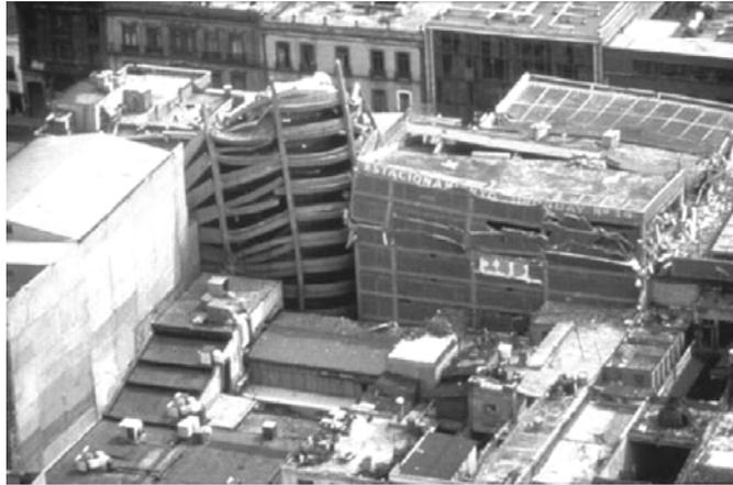
Photo n°2 : Séisme de 1985 à Mexico : effondrement vertical d'un immeuble
