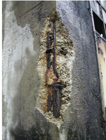
Figure 2 : Photographie d'un parement présentant une armature métallique mise à nu, Soufflerie de l'ONERA, Meudon
