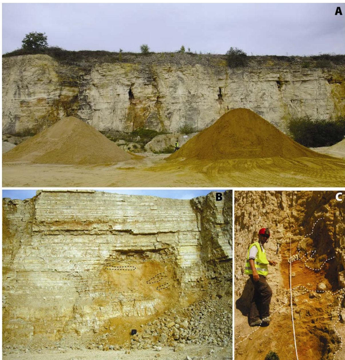
Figure 35 - Exemples de cavités d'un paléokarst crétacé (carrière de Peusec) résultant de la vidange du fantôme de roche et de son remplacement par des sables marins ou alluviaux. Alignement de cavités perchées sur le front de taille qui témoignent d'un paléokarst crétacé en partie colmatée par des sables et des argiles du Cénomaniens (A) (Cliché B. Losson, 16 septembre 2011). Colmatage par des sables lités fluviaux. Les sables attestent une phase fluviale soit qui a rempli le pseudo-endokarst préalablement évacué, soit qui est à l'origine de l'évacuation des altérites in situ (B) (Cliché G. Dandurand, 14 janvier 2007). Sables fluviaux grossiers qui colmate une petite cavité préalablement évacuée partiellement de ses fantômes de roche (C) (Cliché R. Maire, 24 mai 2011).
