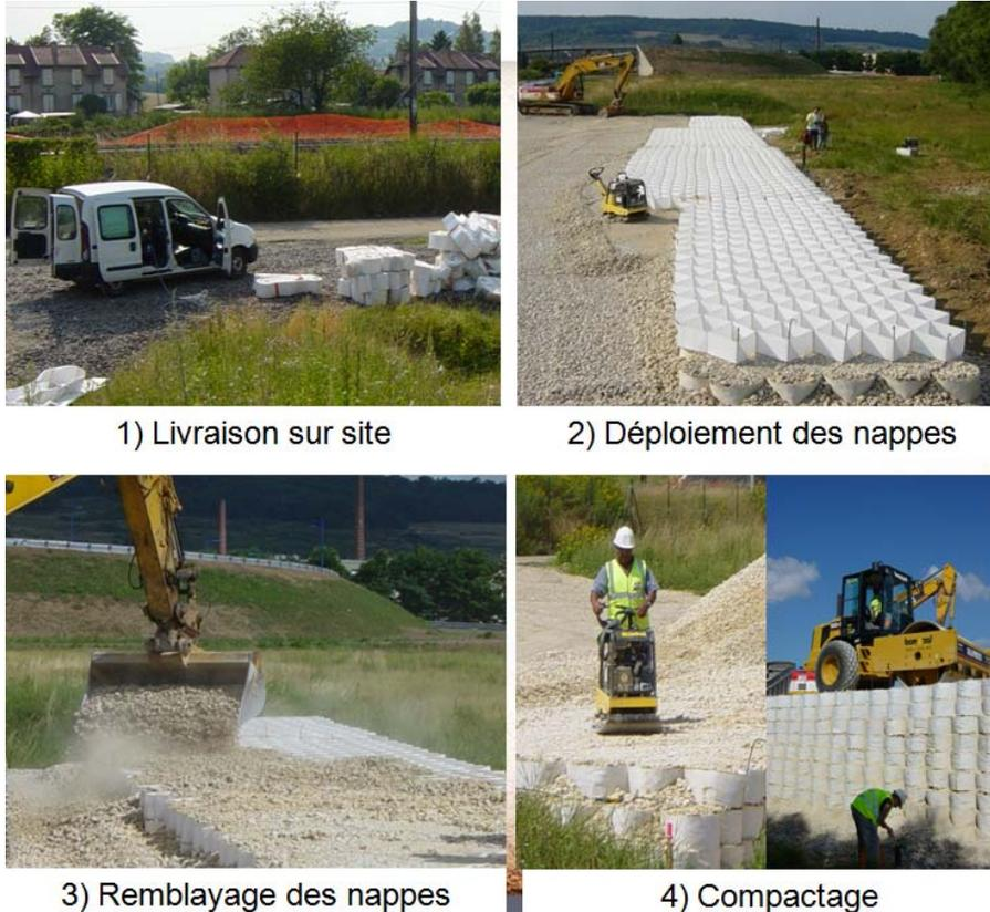
*Figure 4. Etapes de mise en œuvre.*
