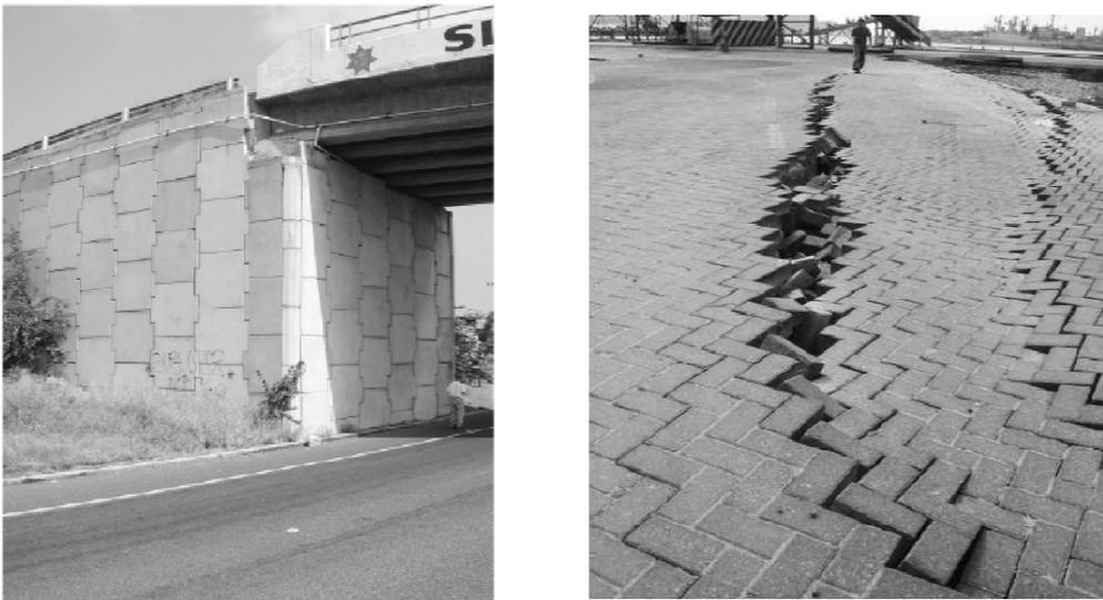
**Figure 24. (gauche) Résistance d'un ouvrage terre-armée après un séisme de magnitude 7,5 à Tecoman au Mexique en 2003 – (droite) Etat d'un quai du port de Tecoman [BAS 09].**
