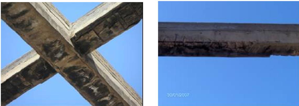
**Figure III-32** Poutres endommagées
