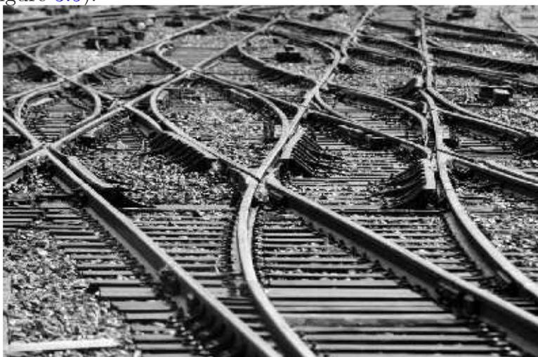
FIGURE 3.4 – Aiguillages en entrée de gare
