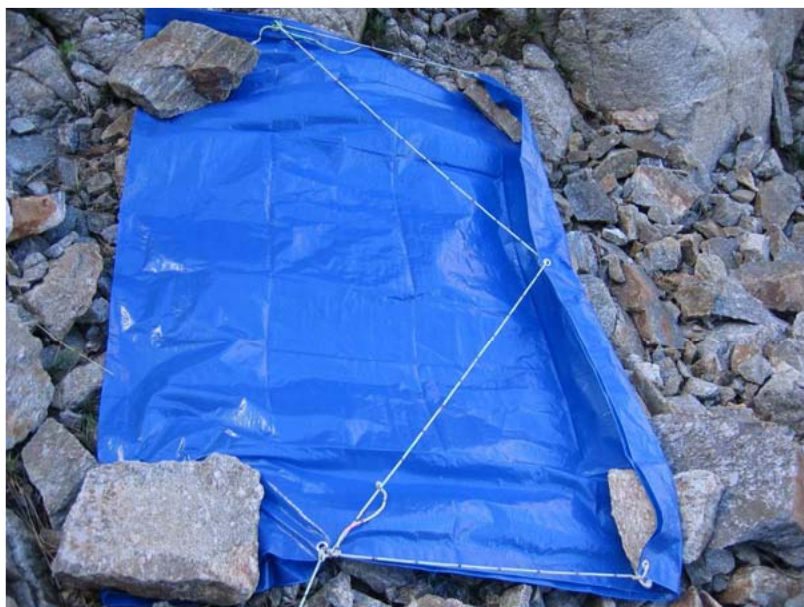
Bâche installée le 03/07/05
