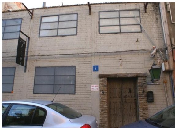
Figure 88 : Beit Uriel, entrée et façade de la salle de réceptions, rue Uriel Akosta, Florentin, 2008.
