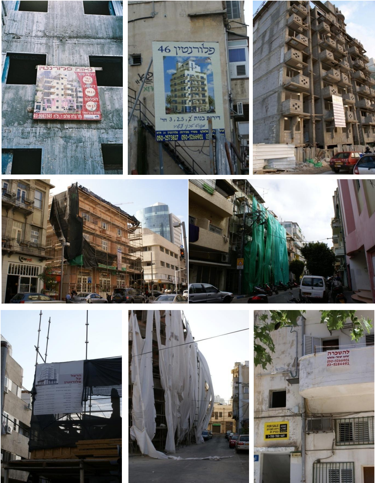
Figure 19: A – H de gauche à droite et de bas en haut : Panneau et travaux de construction rue Abarbanel ; panneau sur un emplacement libre rue Florentin ; bâtiment construit rue Abarbanel ; rue Herzl réfection d'un bâtiment et ouverture d'un nouvelle succursale de Bank Ha'poalim ; réfection d'un bâtiment rue Ben Benishti ; panneau d'annonce de la construction d'un bâtiment au coin Herzl Florentin ; travaux de réfection d'un bâtiment dans la zone industrielle ; panneau à vendre et à louer rue Ben Benishti. Les clichés A à G ont été pris entre 2007 et 2008. Le dernier cliché date de 2006.
