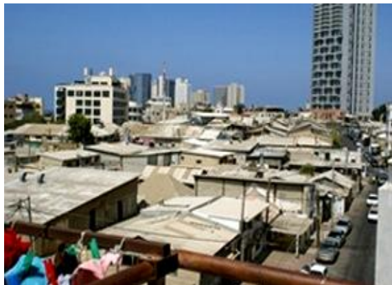
Figure 30 : Le quartier de Florentin avec la zone industrielle au premier plan. « Loin » de la Ville blanche, cet espace – Shrunat Wolowelsky – s’étend jusqu’à la rue de Jaffa et la tour Neve Tseddek à droite sur le cliché, 2008.
