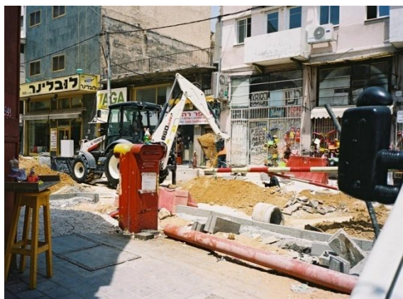
Figures 16 : A et B – Réfection de la rue Herzl. Avancement des travaux à plusieurs mois d'intervalle, Florentin, mai 2006 (haut) et 2005 (octobre).
