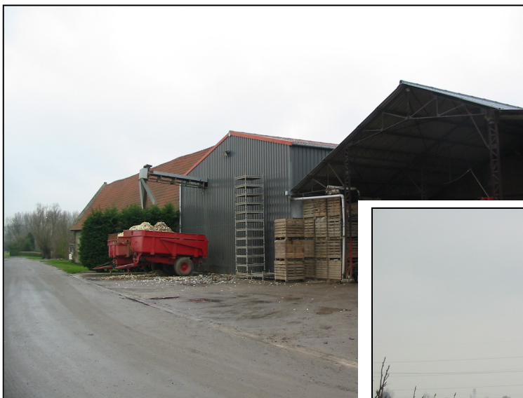
Photographies n° 1 et 2. Louvil (59). A l'atelier de production hydroponique est juxtaposé un atelier de forçage « traditionnel ».
