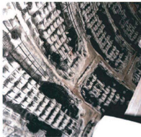
**FIG. 1.32:** Ecaillage observé lors de l'incendie du tunnel sous la Manche [13].
