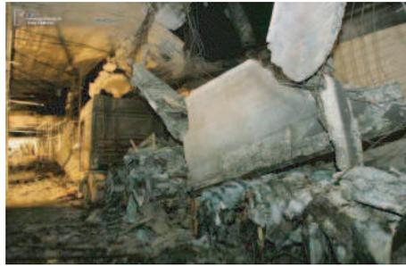
**FIG. 1.33:** Rupture de la structure du tunnel du Tauern (Faure et Hemond).
