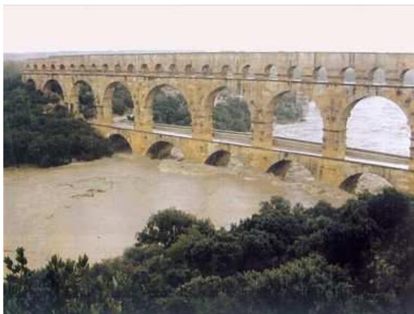
FIG. 3.10 : Photographie du Pont du Gard avec le Gardon en crue pour l'évènement du 8 au 9 septembre 2002. L'eau atteignait le haut de la première arche du pont, soit une hauteur d'environ 20 mètres...
