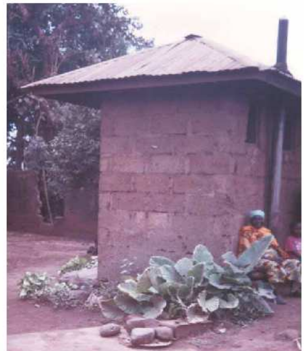
Latrines haut standing (VIP)
