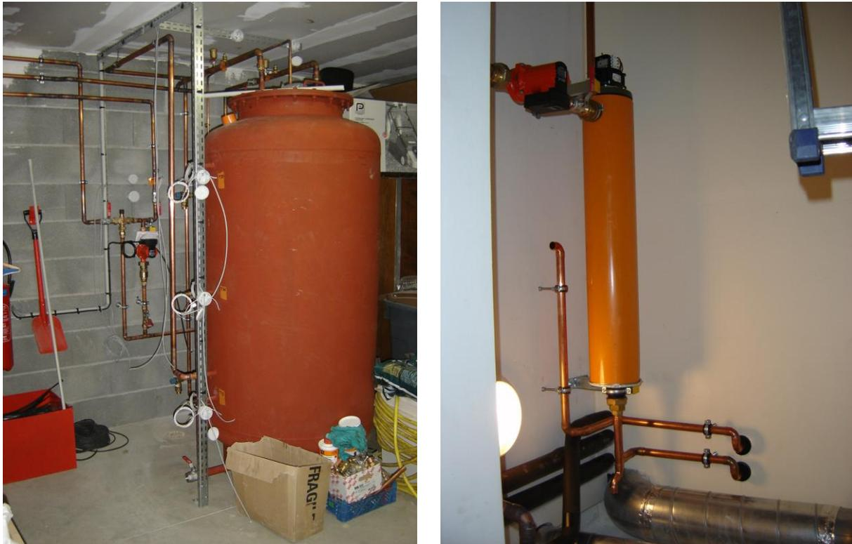
Figure 4. 20 : Ballon de stockage avant son isolation et la batterie électrique pour la régénération.
