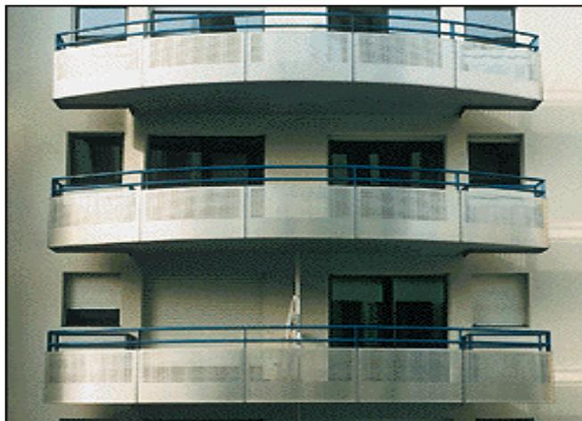
Figure 3-24 : Tôles perforées en inox pour remplissage de garde-corps
