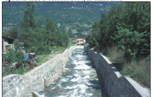
D. Fénis, en aval du pont de Cerise, endiguement du Clavalité après la crue d'octobre 2000, 13 mai 2003
