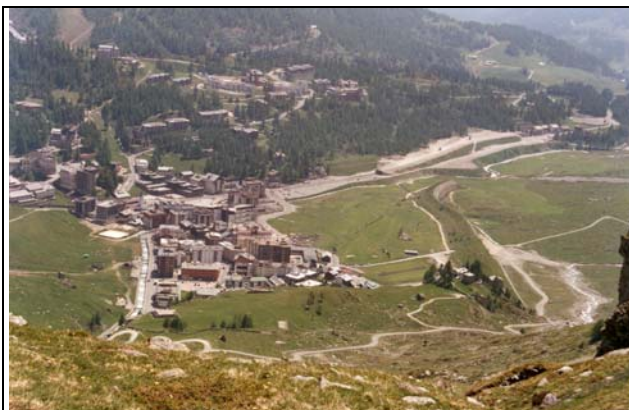
A. Breuil, digue et tunnel paravalanche, mai 2003
