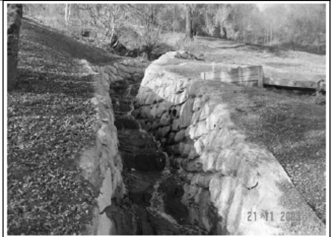
B. Hérémece, torrent de Tzénaz après travaux suite aux crues des 12 et 14 juin 2003
