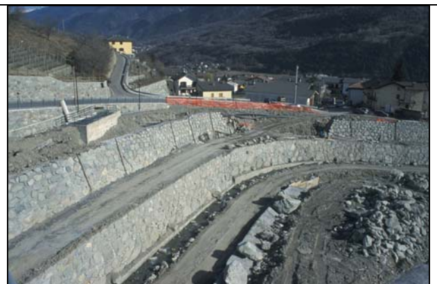
B. Nus, travaux d'endiguement du Saint-Barthélémy après la crue d'octobre 2000, 13 mars 2003
