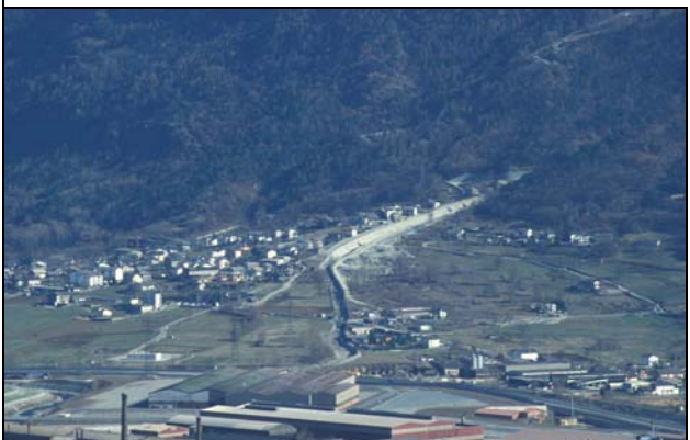
C. Pollein, canalisation du Comboé après la crue d'octobre 2000, 15 mars 2003
