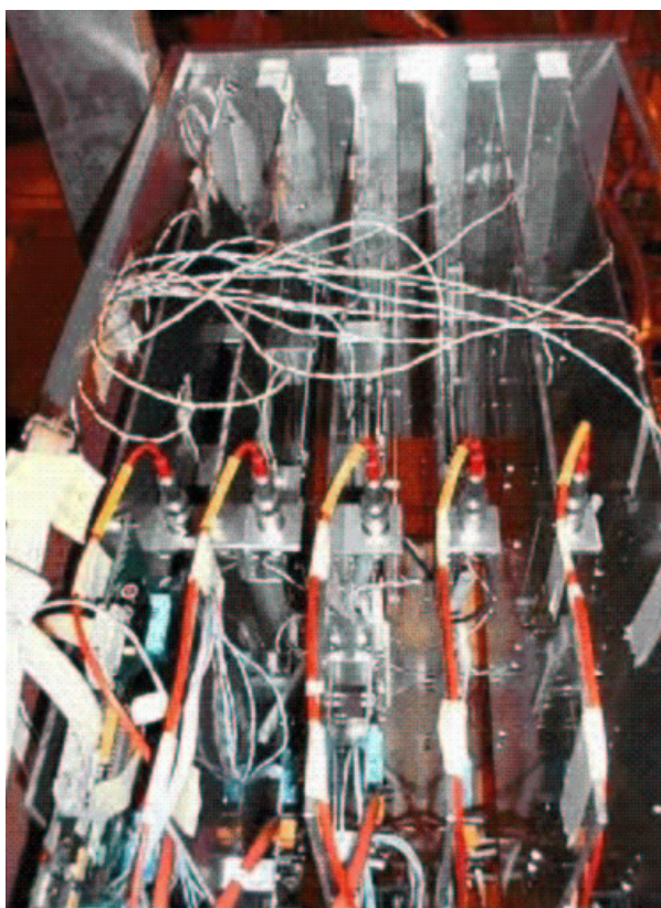
Figure 4.12 – Installation des modules au CERN.
