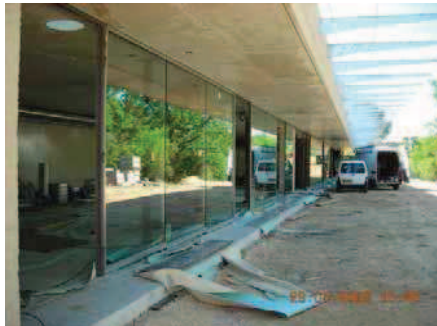
Pose des vitrages, Avril 2008
