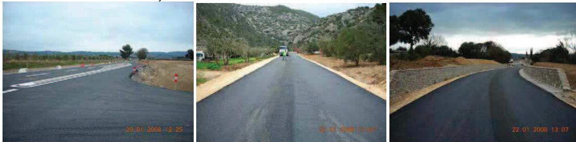
Création du carrefour en T à l'entrée du parc de stationnement et Nouvelle route départementale
