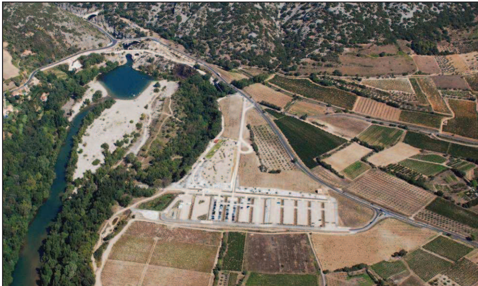
Fig. 4.14 – Photographie aérienne du Pont du Diable et de ses abords, où l'on observe le projet d'aménagement mis en place. Source : CERPA, C. Renard et A. Humbert, août 2010.
