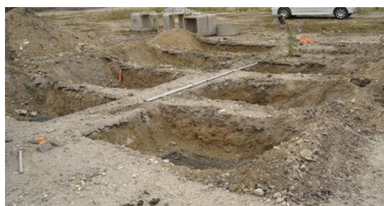
Figure IV-27. Décaissement de la couche de remblai
