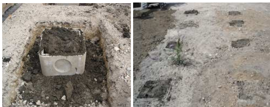
Figure IV-29. Remblaiement des regards en béton
