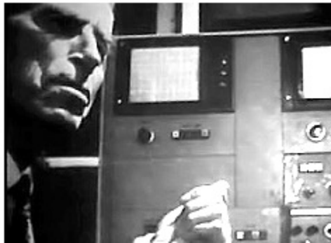
Figure 19 : Le Dr. Donald et le système NE 4102. Un des tous premiers échographes industriels.
