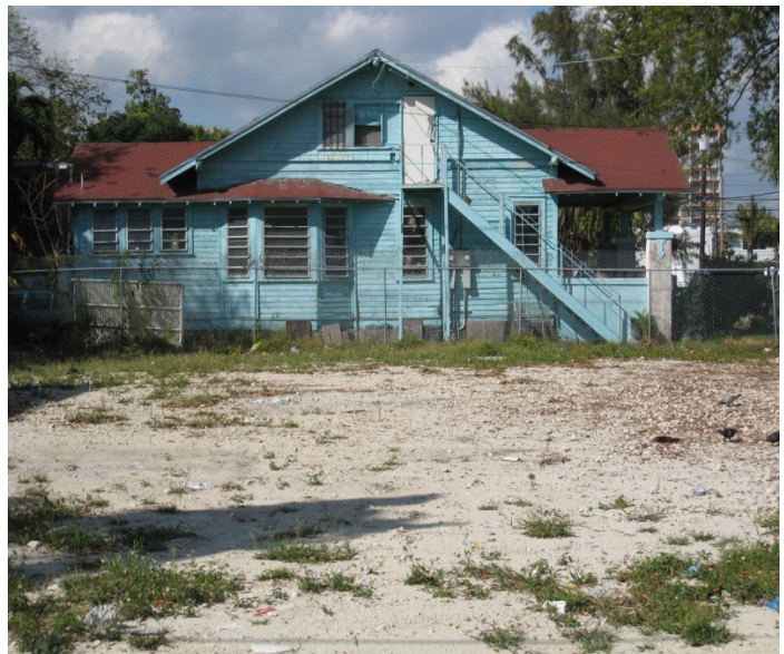
Photo 9 : Habitat traditionnel dégradé et lot vacant
