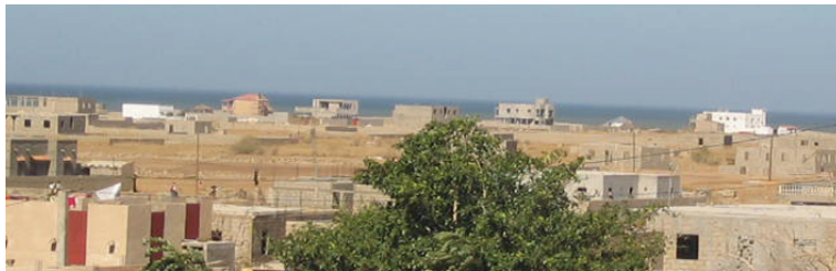
Photo 40 : Résidences secondaires en construction
