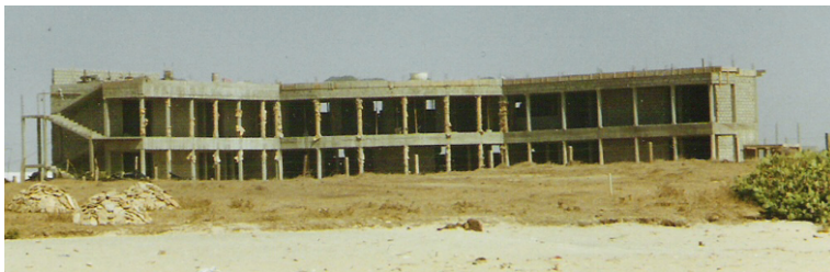
Photo 42 : Hôtel en construction en 1997
