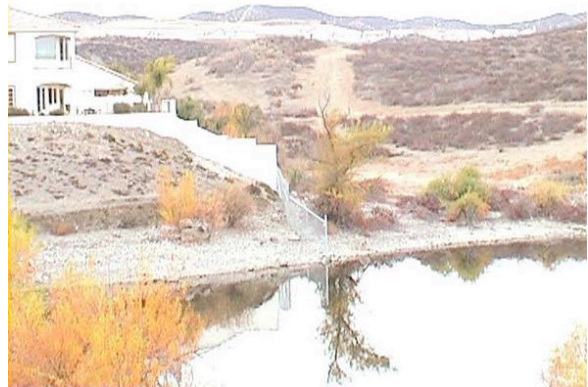
d. Une faille dans la sécurité au bord du lac à Canyon Lake, le grillage s'interrompt et ne traverse pas les eaux, propriété publique.
