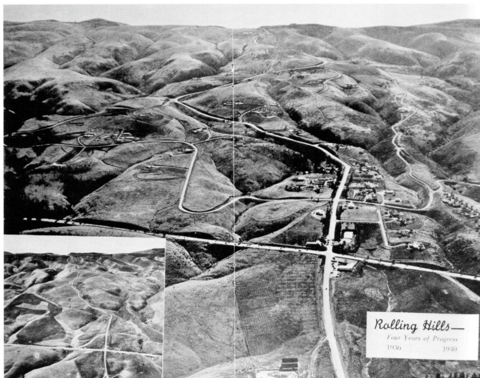
Figure II.6 — Photographie de l'avancement des travaux à Rolling Hills en 1940.
