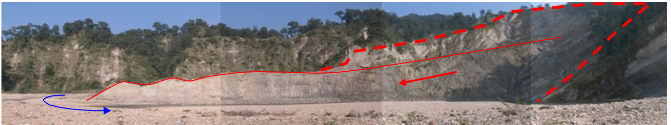
Figure 33 : Photos du glissement de terrain majeurs de 2005 dans les gorges de la Bakeya.
