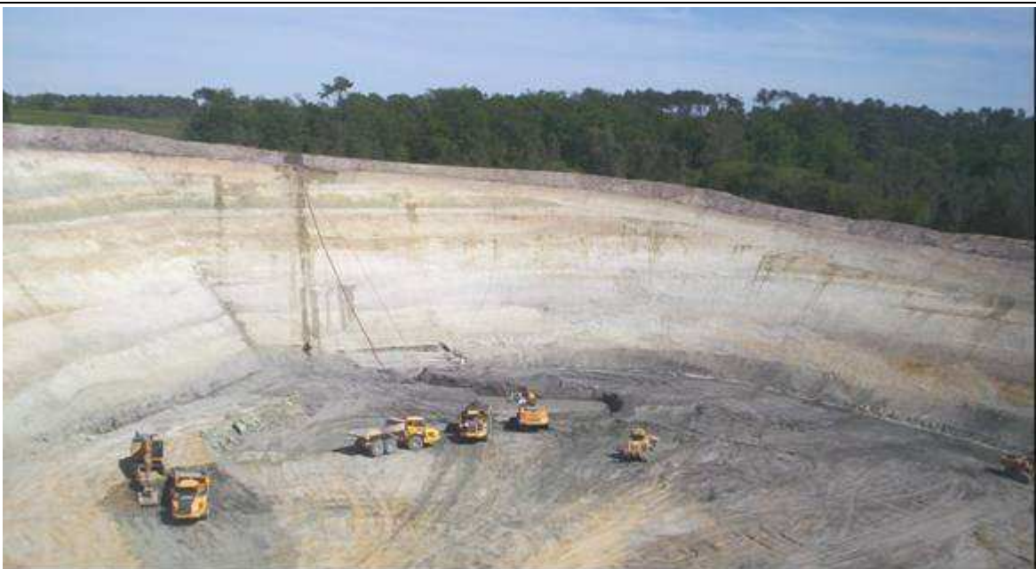
figure II.7 Opération de découverte du sable dans la carrière de Bois des Rentes (BDR), le taux de recouvrement est 5.5 m 3 /t d'argile
