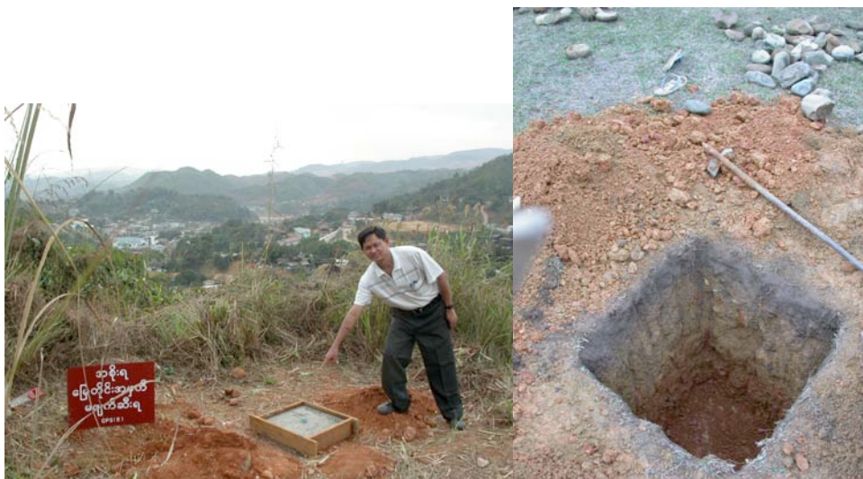
Figure A2-4: Monumentation d'un site GPS. A gauche, le pilier de béton et le marqueur en son centre (site HPAA). A droite, un trou creusé dans le sol avant d'y couler le béton du pilier (site PUTA)
