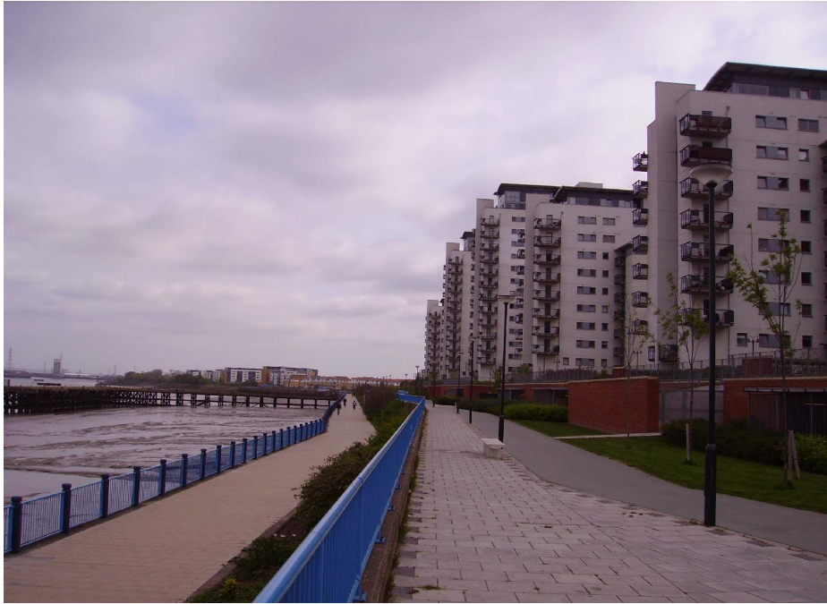
Figure A.22 : Woolwich, quartier du Royal Arsenal. (Cliché S. Beucher, avril 2007).
