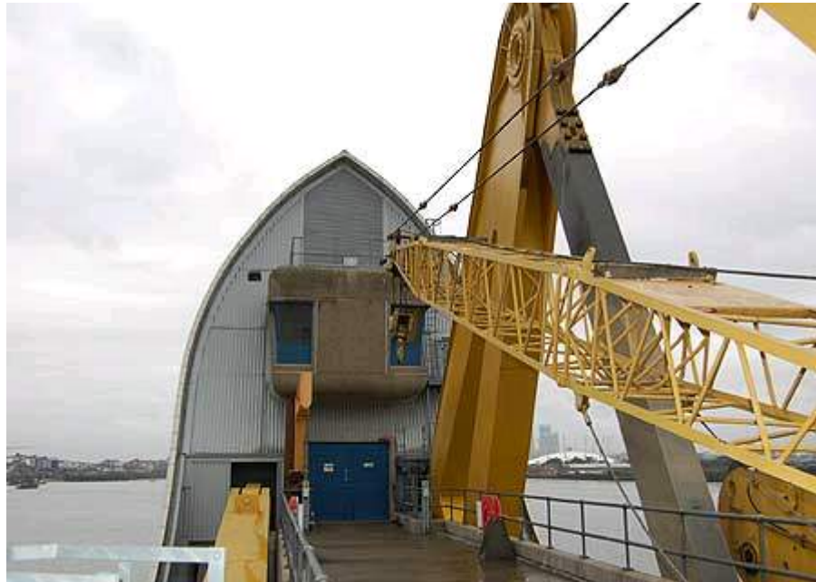
Figure A.3 : Une des tours de contrôle permettant d'actionner la Thames Barrier (Source : BBC)
