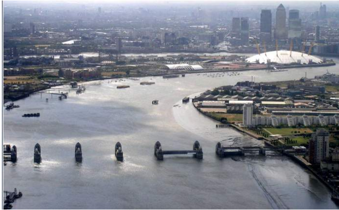
Figure 1.34 : La Thames Barrier à Woolwich (Source : Agence de l'Environnement)
