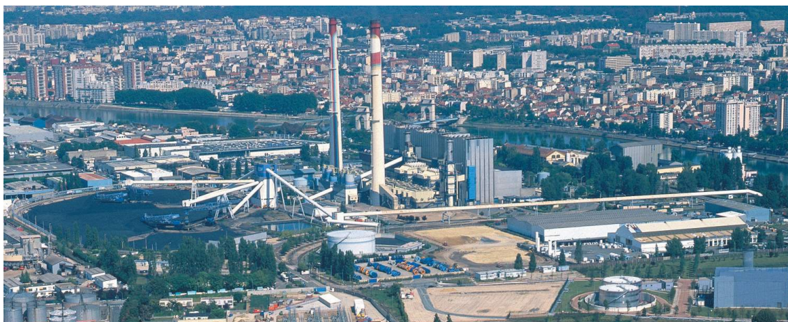
Figure 3.35 : Centrale EDF (Source : commune de Vitry-sur-Seine).
