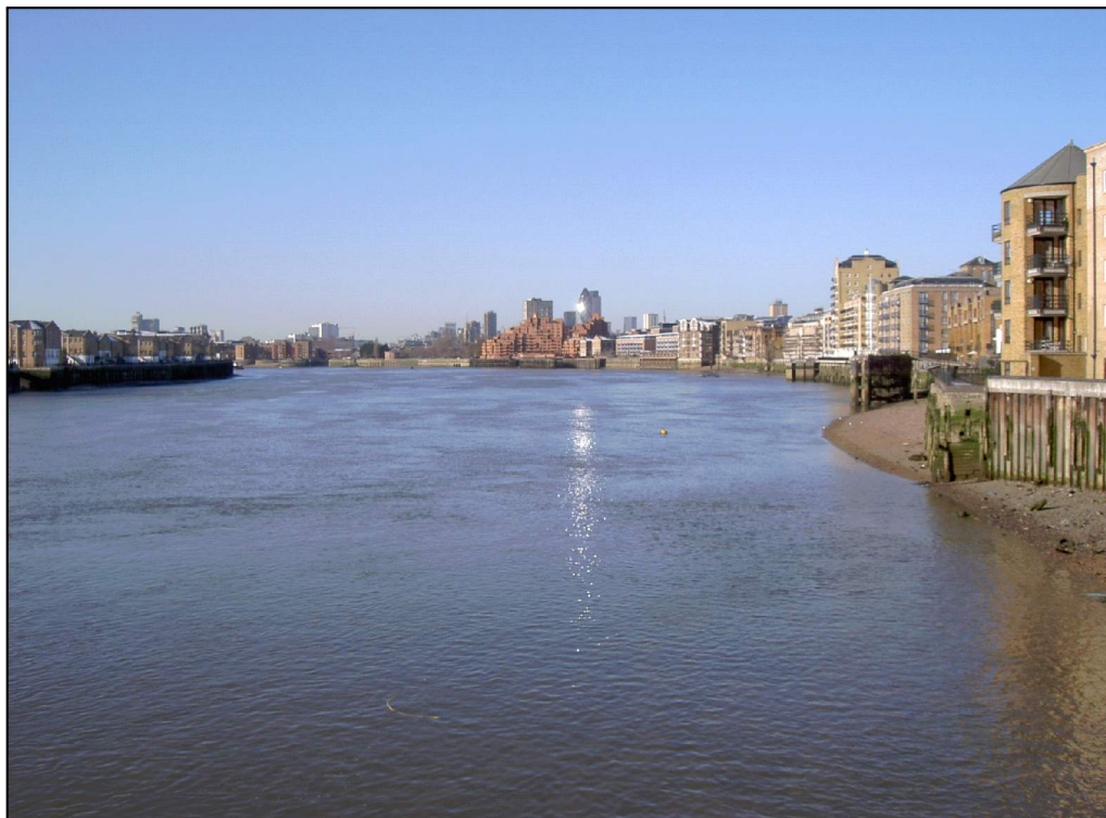
Figure 1.32 : Les rives de la Tamise en aval de Londres : un linéaire d'immeubles construits juste derrière les digues. (Source : Thames Estuary Partnership)
