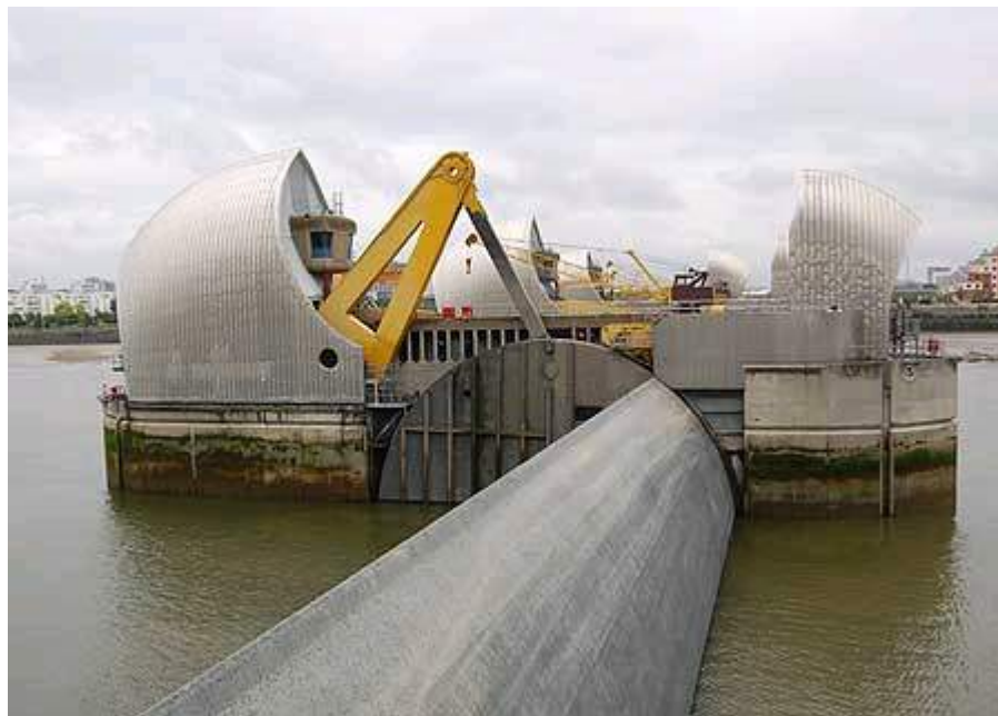
Figure A.2 : La Thames Barrier en position fermée (Source : BBC).
