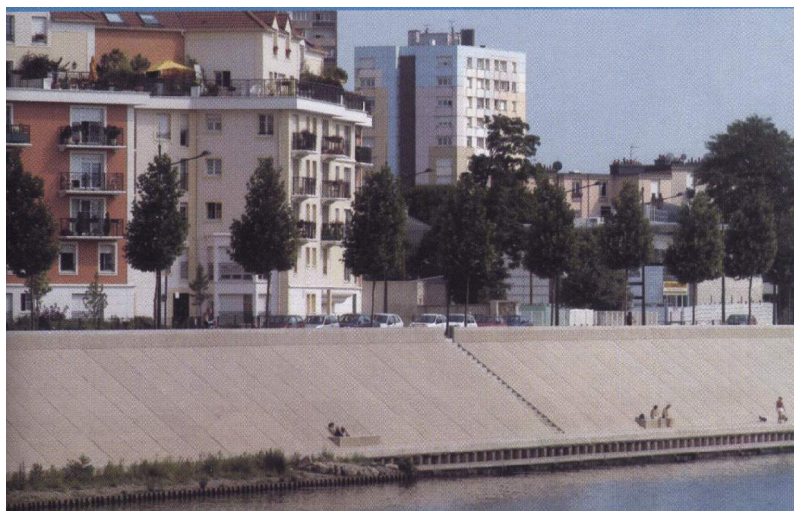
Figure 1.23 : Les murettes anti-crue du quai Blanqui à Alfortville (Source : plaquette d'information de la commune)
