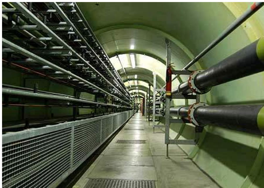
Figure A.4 : Le tunnel permettant de relier les différentes tours de contrôle (Source : BBC)
