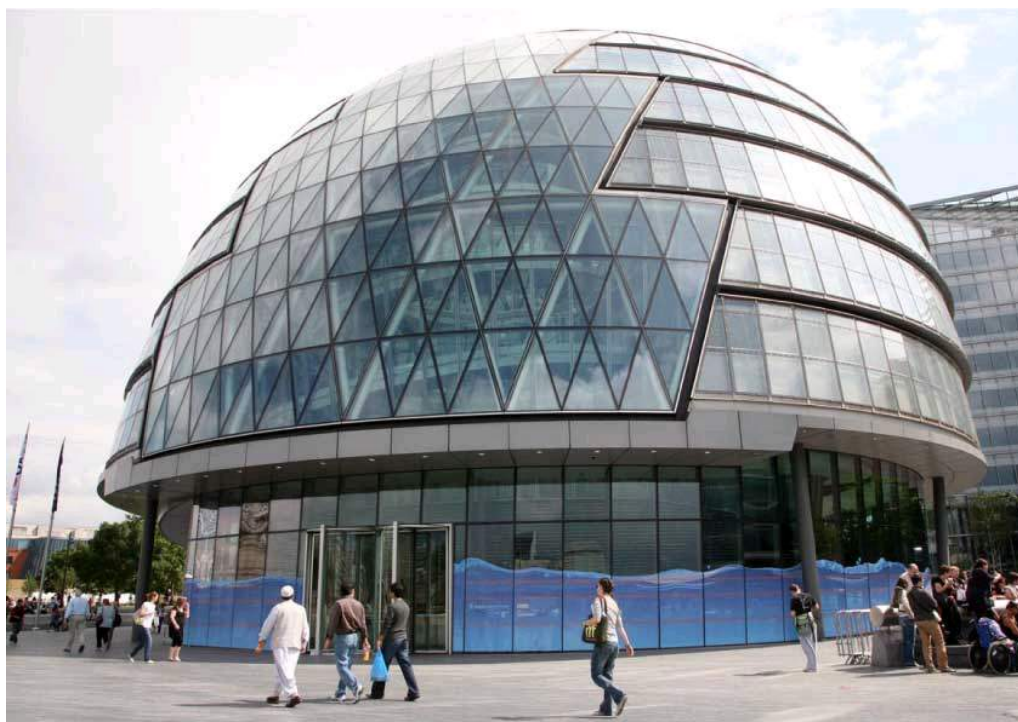
Figure 2.5 : Les hauteurs d'eau pouvant être atteintes par des inondations de différentes occurrences au niveau du City Hall, s'il n'y avait pas d'infrastructures de protection. (Source : Barker Cou tts Architects , 2007).
