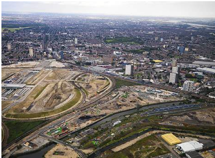
Figure 3.51 : Recompositions du paysage autour de la gare de Stratford (Source : BBC, 2007).
