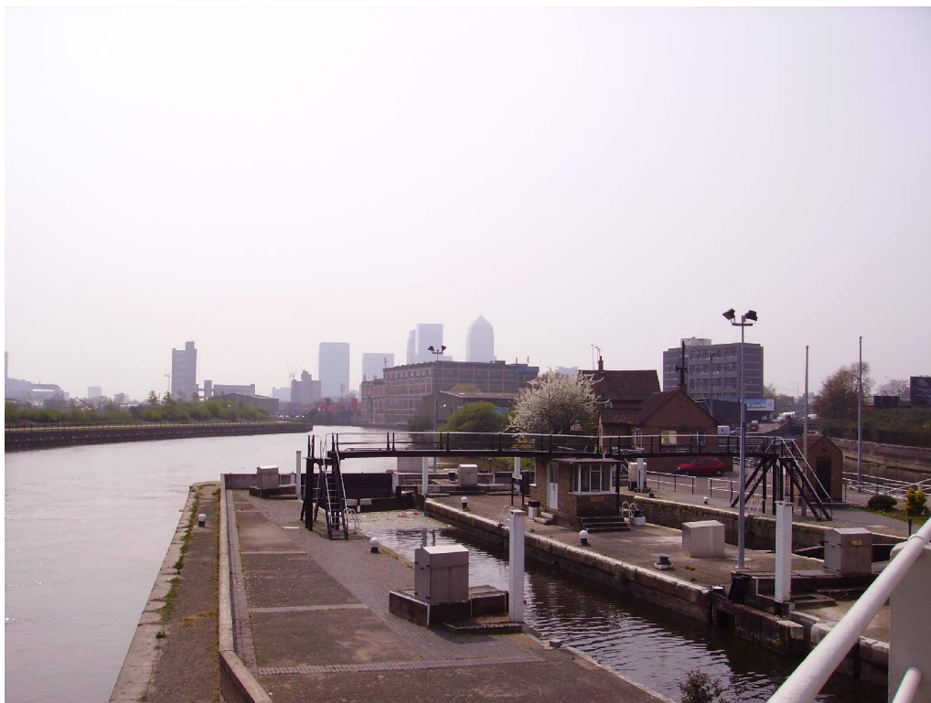
Figure 1.33 : La rivière Lea : une rivière aménagée pour la navigation (écluse de Bow). (Cliché S. Beucher, juillet 2006)
