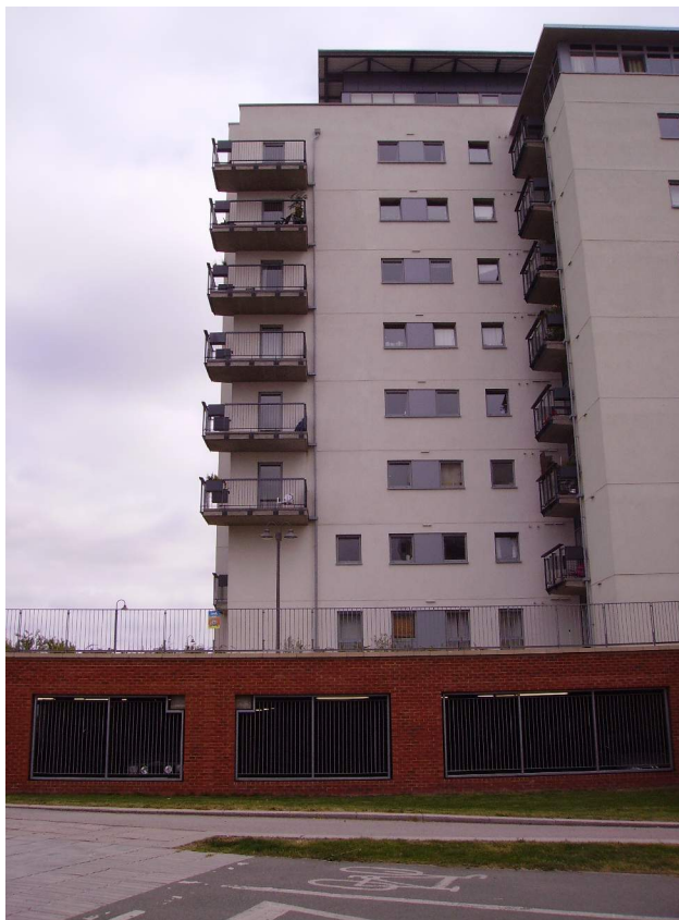
Figure A.23 : Woolwich, quartier du Royal Arsenal, parkings. (Cliché S. Beucher, avril 2007).
