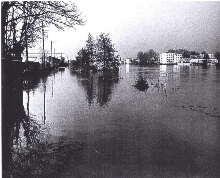
Figure 1.25 : Inondations de janvier 1982. Quai de Choisy (Source : Service urbanisme de Choisy-le-Roi)
