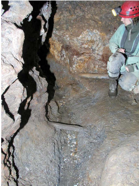
Fig. n°2 : Rigole d'écoulement de la Galerie d'exhaure Primitive (cl. B. Ancel).
