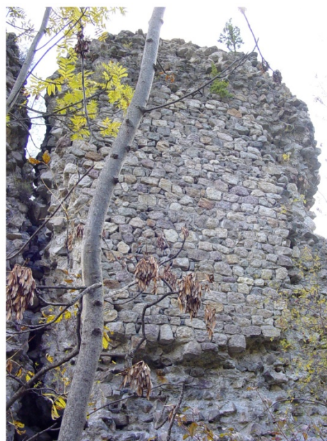
d. Détail du parement et de la maçonnerie du donjon
