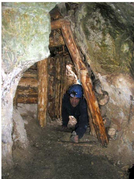
Fig. n 1 : Boisages installés à l'entrée de la galerie d'accès de la Pinée (cl. B. Ancel).
