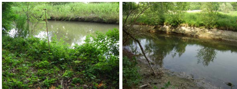
FIGURE 3.7 – Diminution des niveaux d'eau sur le site de Vacluse, avant (gauche) et après (droite) l'effacement du clapet Vacluse
