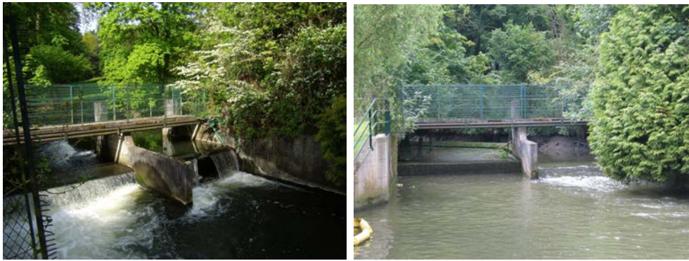
FIGURE 2.10 – Clapet Vaucluse avant et après effacement (vue vers l'amont)
