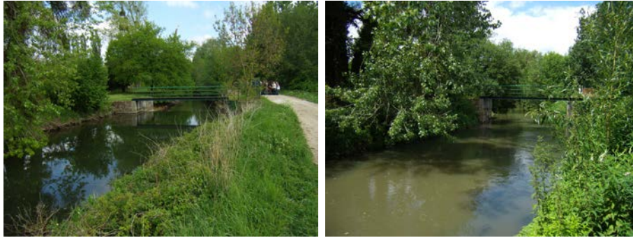
FIGURE 2.8 – Clapet Guipereux en place et après effacement (vue vers l’aval)
