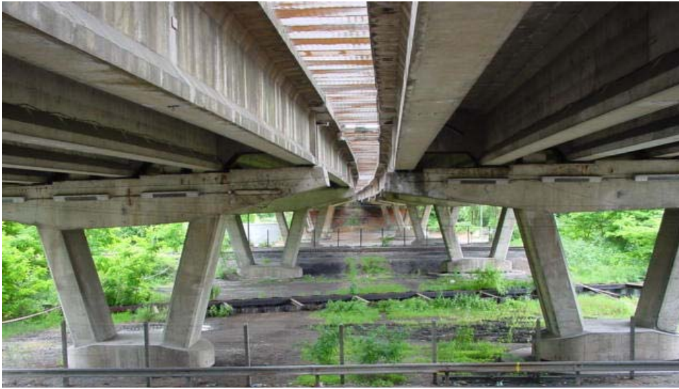
Figure 4.60. Viaduc de Merlebach.
