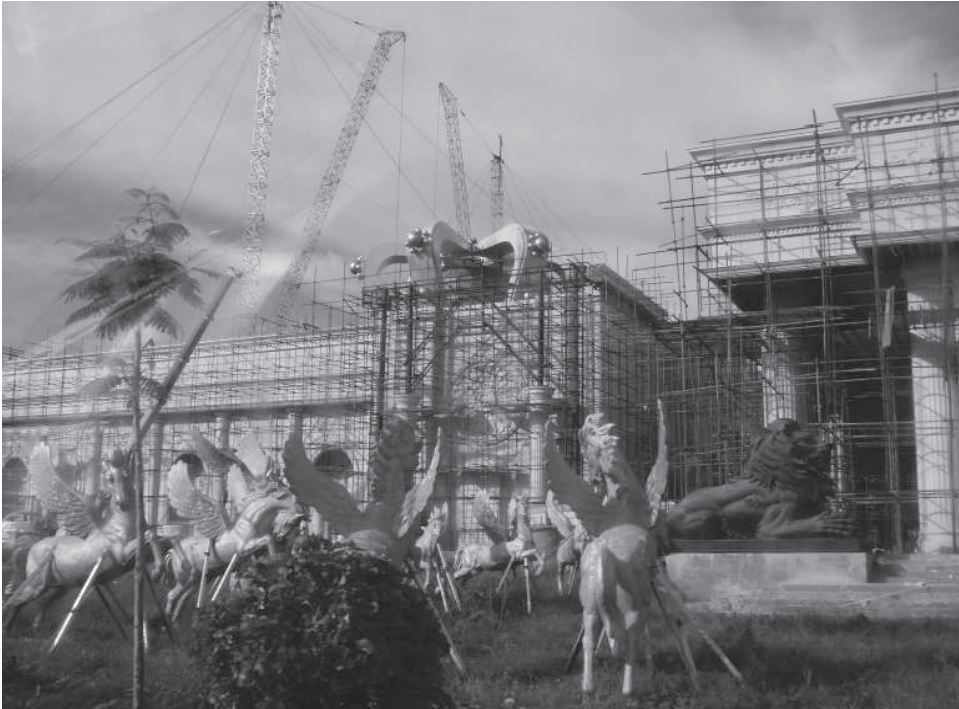
Construction du casino
