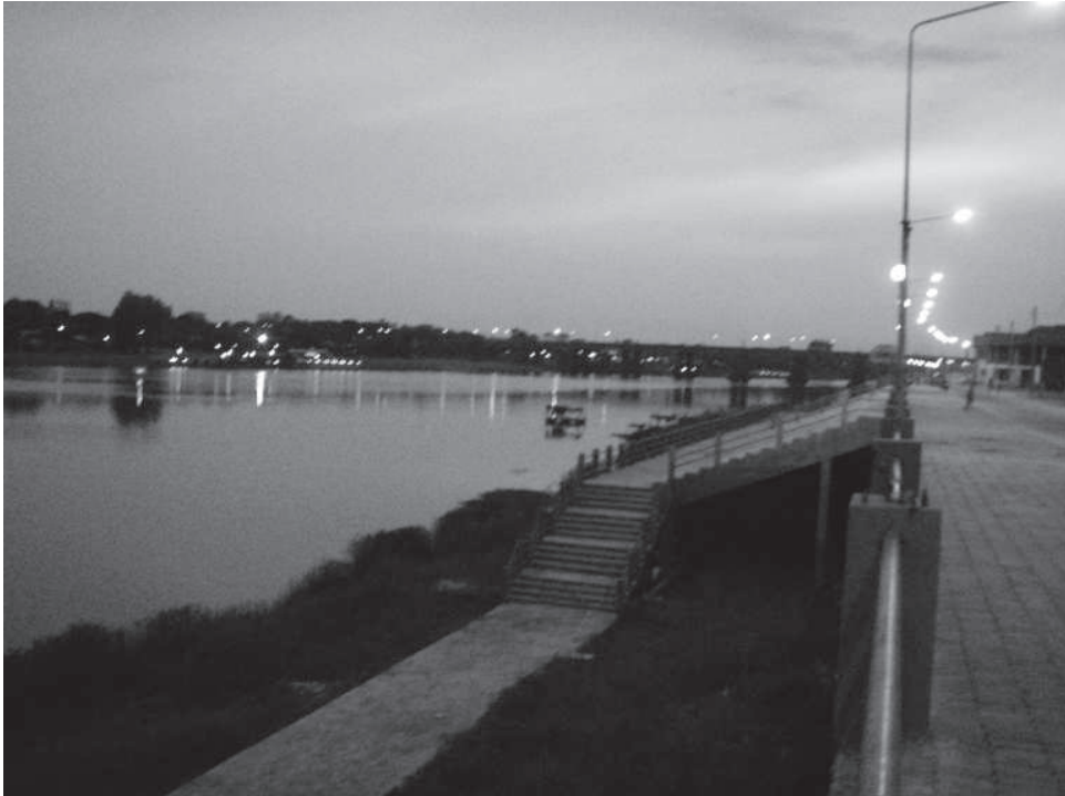
Les quais de la rivière Mun
