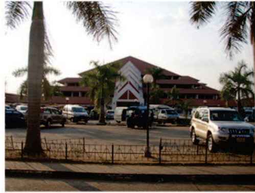
Bâtiment du marché Savanxay (2009)
