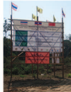
Pont de Chiang Khong-Houay Xay, en construction. Cofinancement thaïlandais et chinois (2011)
