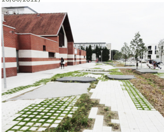
Figure 50 : Écoquartier de Mons-en-Baroeul, revêtements perméables (Photo : Leger-Smith, visite de site 28/06/2012)
