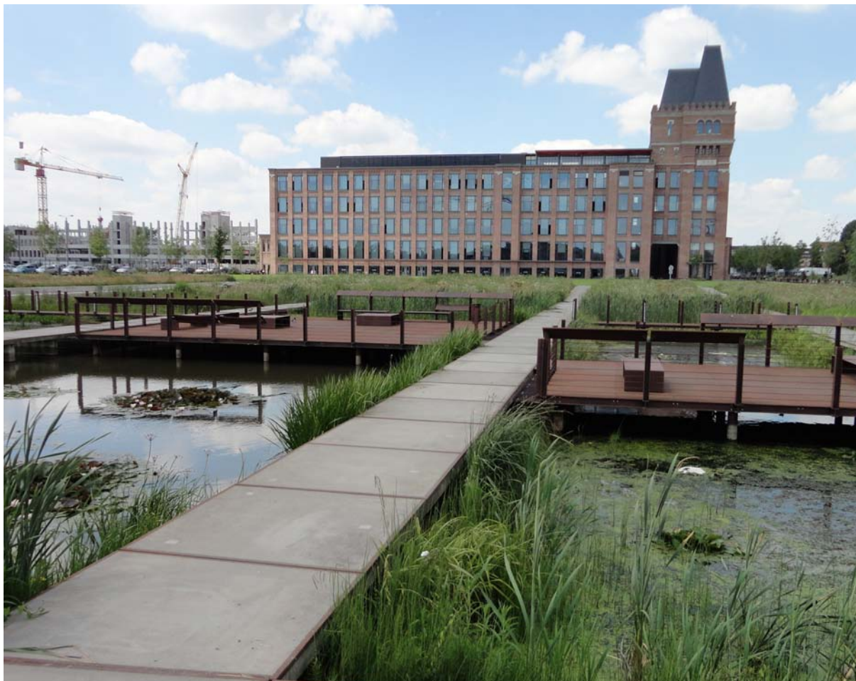
Figure 45 :Écoquartier de la Haute Deûle, Lille, Bassin de stockage des eaux pluviales (Photo : Leger-Smith, visite de site 01/06/2012)
