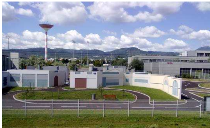
FIGURE 3.15 – Plate-forme expérimentale PAVIN
