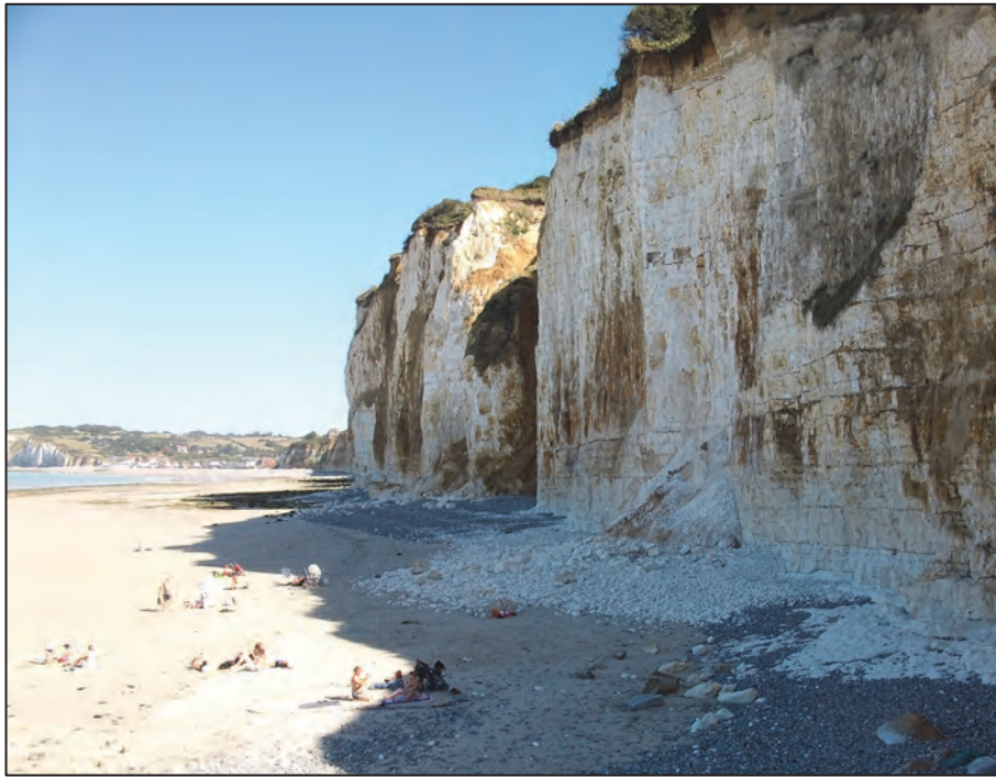
Figure 8.1 : Estivants installés en pied de falaise à proximité d'un éboulement au Petit Ailly à Varengeville-sur-Mer (ESTRAN, 31/08/2009)
