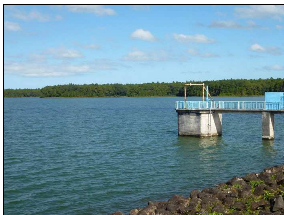
Photographie 6 : Le réservoir de la Mare aux Vacoas (Maurice)
