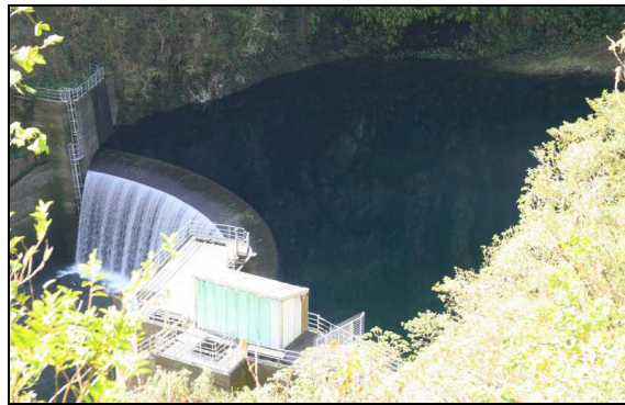
Photographie 4 : Vue du barrage hydroélectrique de Takamaka I (Réunion)
