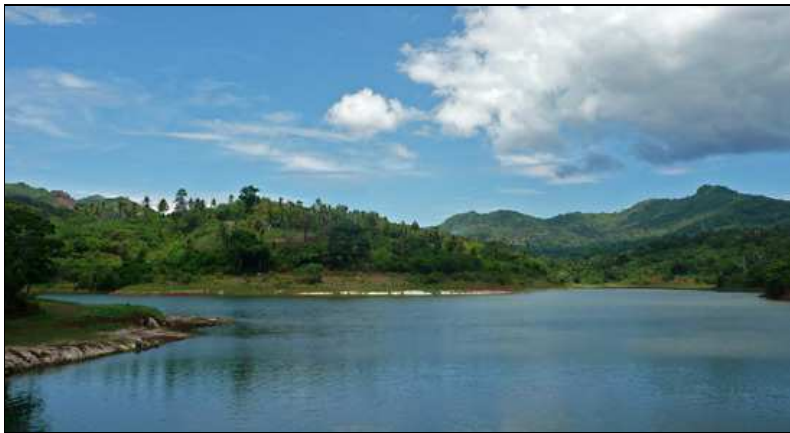
Photographie 50 : Réservoir de Combani (Mayotte)
