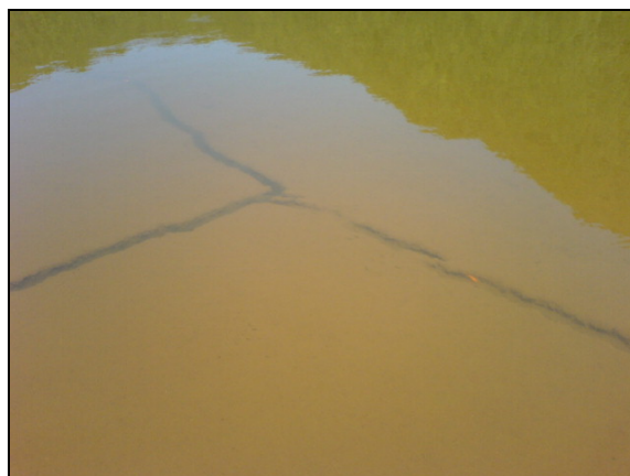
Photographie 24 : Fissuration de la couche sédimentaire dans le Grand Etang Cliché Mathelin, 2007
