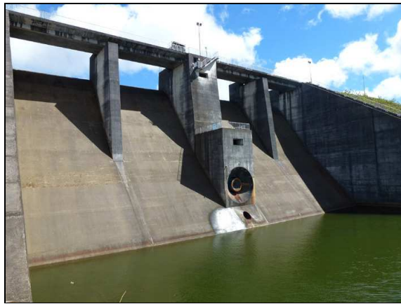
Photographie 23 : Déversoir de surface et de crue du réservoir des Midlands (Maurice)
