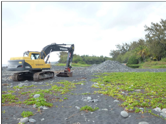
Photographie 60 : Le tractopelle permettant l'ouverture du cordon littoral de l'Étang Saint Paul (Réunion)
