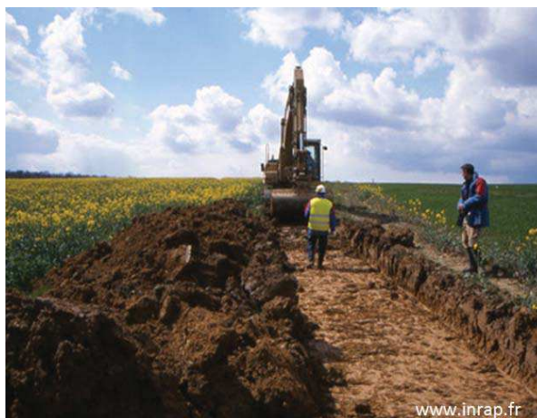
Fig. 20. Décapage de la couche organique.
