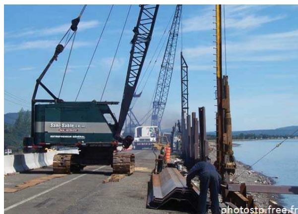
Fig. 21. Rideau de palplanches pour travailler hors eau.
