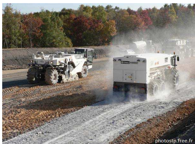
Fig. 23. Traitements aux liants hydrauliques.
