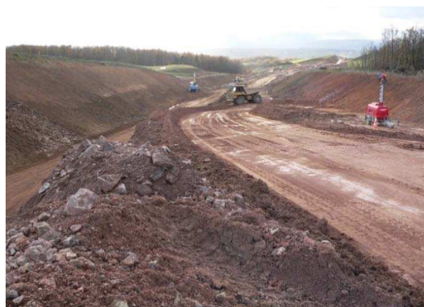
Fig. 22. Zone Déblais/Remblais de la A89.
