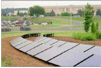
Cellules PV qui fournissent de l'électricité au Pentagone (USA)
