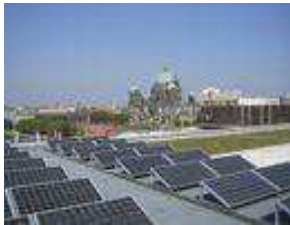
Bureaux équipés de PV en Allemagne
