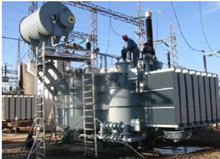
Fig. 4: Transformateurs de puissance
