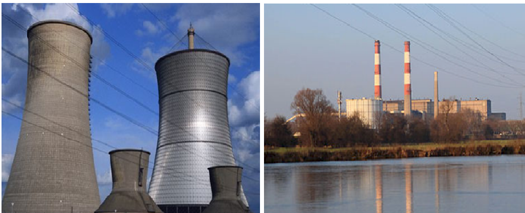
Fig. 2: Centrales électriques (respectivement nucléaires et thermiques)
