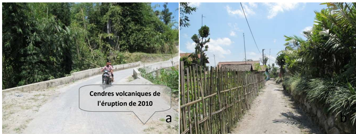
Figure 114. Routes dans la commune de Ngargomulyo: (a) route asphaltée connectant la maille de route connectant la maille 10 D et la maille 10 F, (b) route en terre connectant la maille D et les mailles 10C, 10B, 4A (Photos : Mei, 2011)
