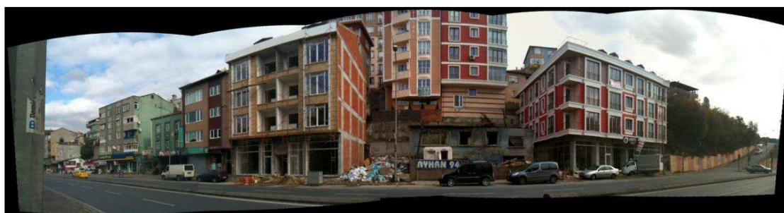
Photo 21: Construction face de Santralistanbul (source : photo personnelle)
