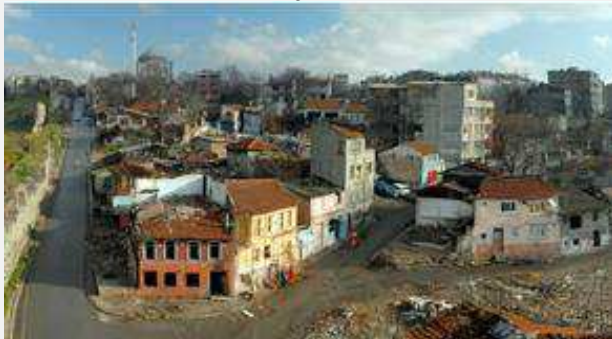
Photo 7: le projet de Sulukule et les démolitions (source : www.ibb.gov.tr )
