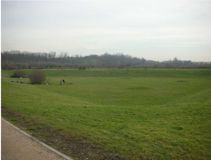
Figure 3: bassin de stockage (sec) des eaux pluviales à Saint Priest (Minerve), photographie personnelle
