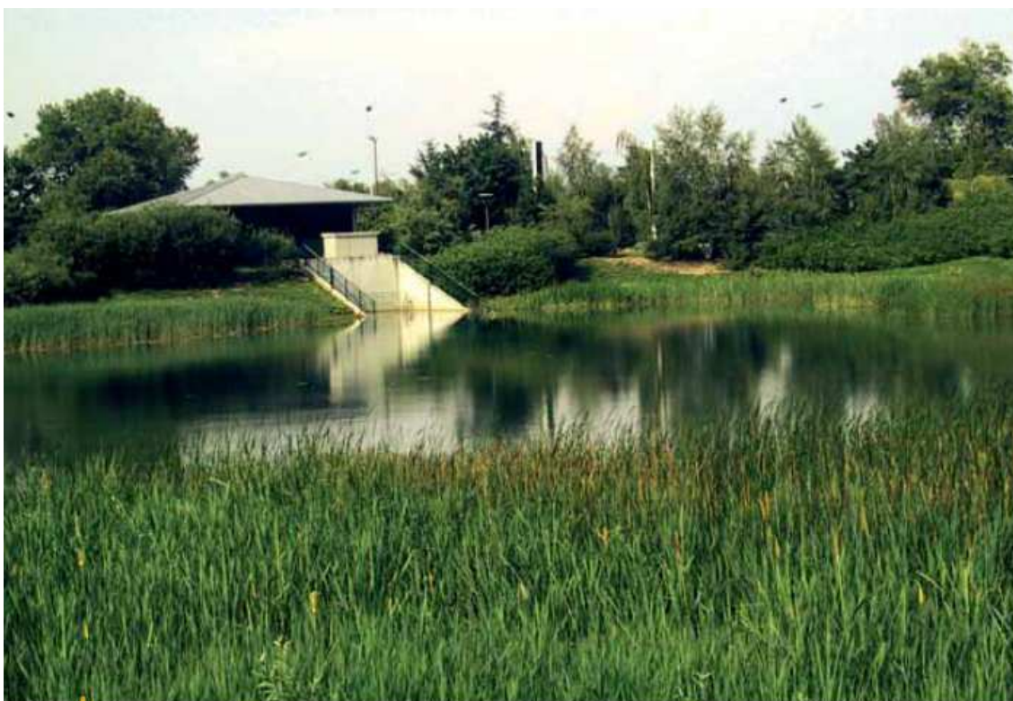
Figure 2 : bassin de stockage (en permanence en eau) des eaux pluviales à Saint Priest (Porte des Alpes), image Grand Lyon
