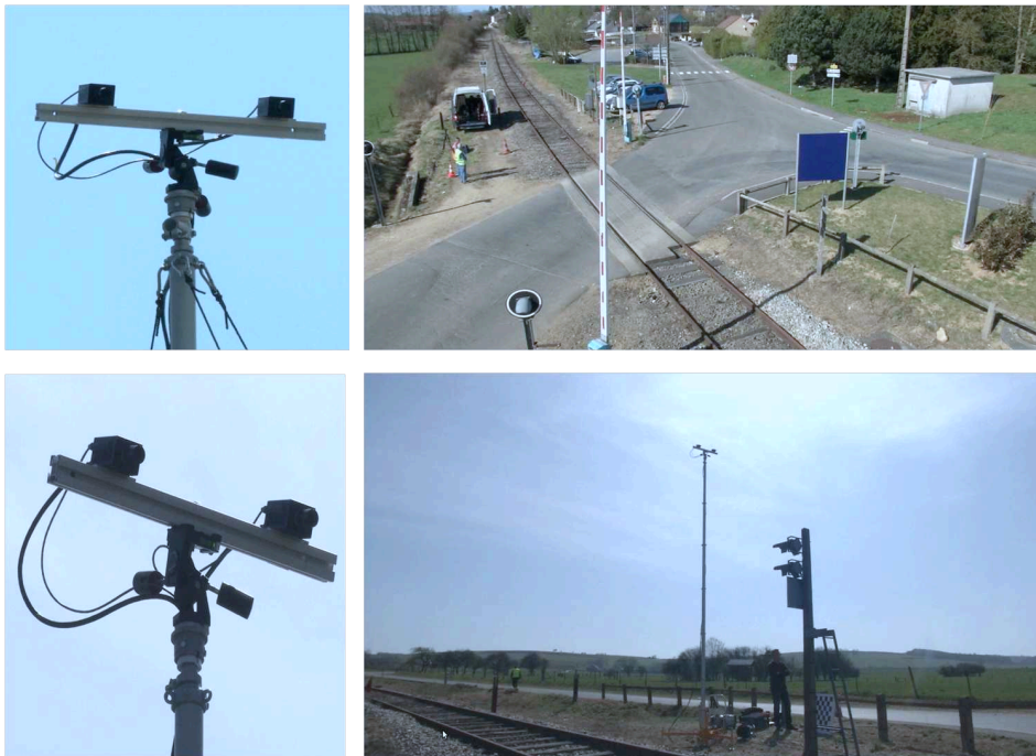
FIGURE 4.9 – Installation du système de perception sur site (Mouzon-France).
