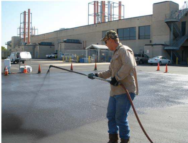
Figure 47 : Application des revêtements « CTB sealcoat » et « ASB sealcoat » (Photo USGS, Austin, Texas)
