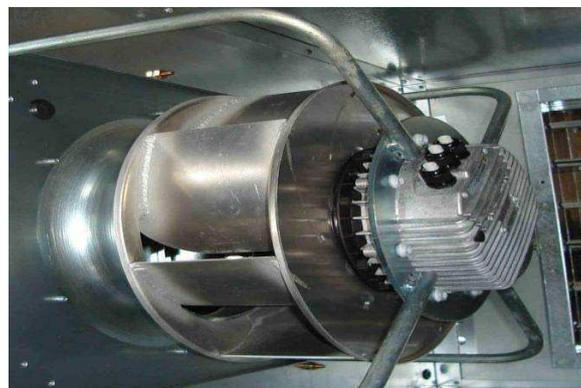
**Figure 2.7. Ventilateur à haute performance**
