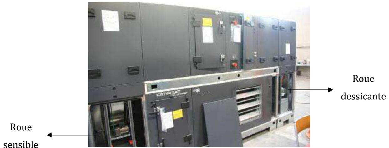
Figure 2.1. Centrale de traitement d'air par dessiccation (CAD)
