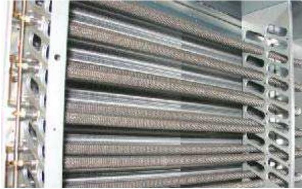
Figure 2.8. Batterie d'Appoint de Régénération électrique (BAR)
