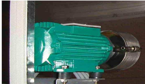
**Figure 2.6. Humidificateur à rotation**
