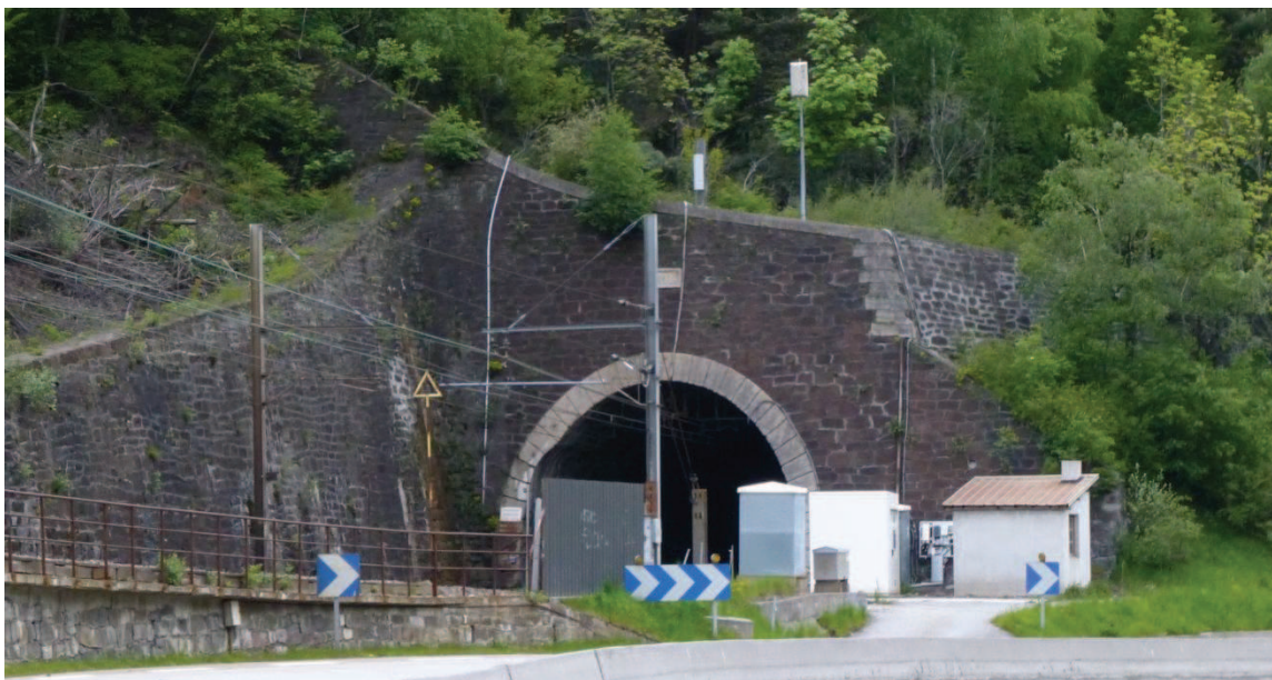
Photographie 34. Entrée du tunnel de la grande muraille (côté Modane) entre Modane et Saint-Michel-de-Maurienne édifié en 1870 (E. Cottet Dumoulin, mai 2013).
