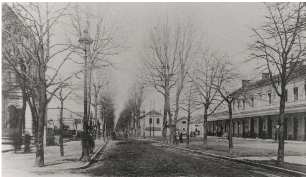
Photographie 43. Extérieurs de la gare de Chambéry à la fin des années 1880 (collection rail.savoie.fr).
