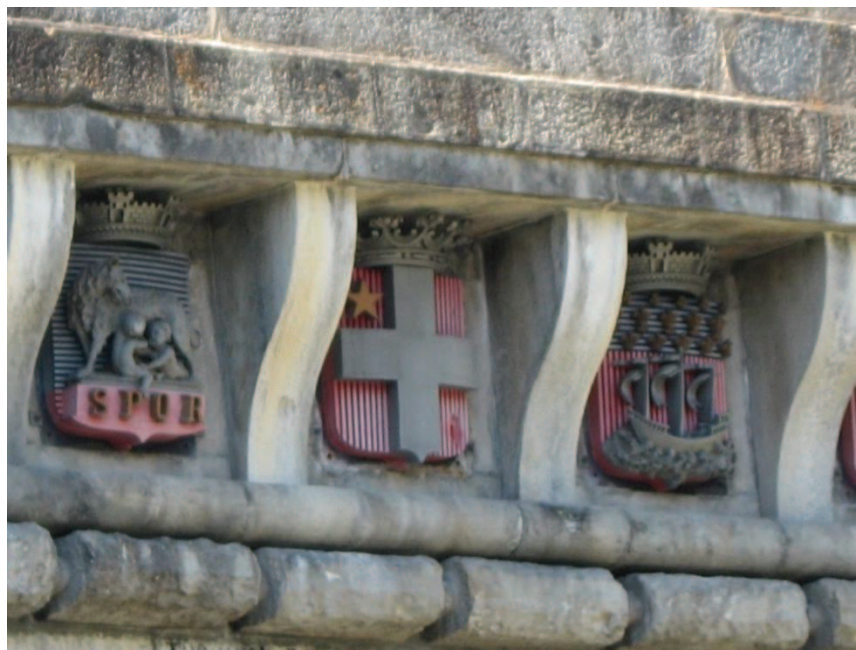
Photographie 22. De gauche à droite : blasons de Rome, Chambéry et Paris (E. Cottet Dumoulin, juin 2011).
