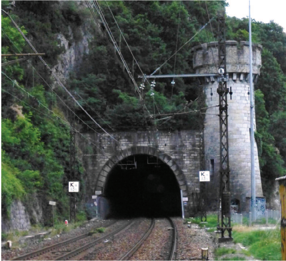
Photographie 31 a. Entrée du tunnel ferroviaire de Brison du côté de Culoz (E. Cottet Dumoulin, juillet 2013).
