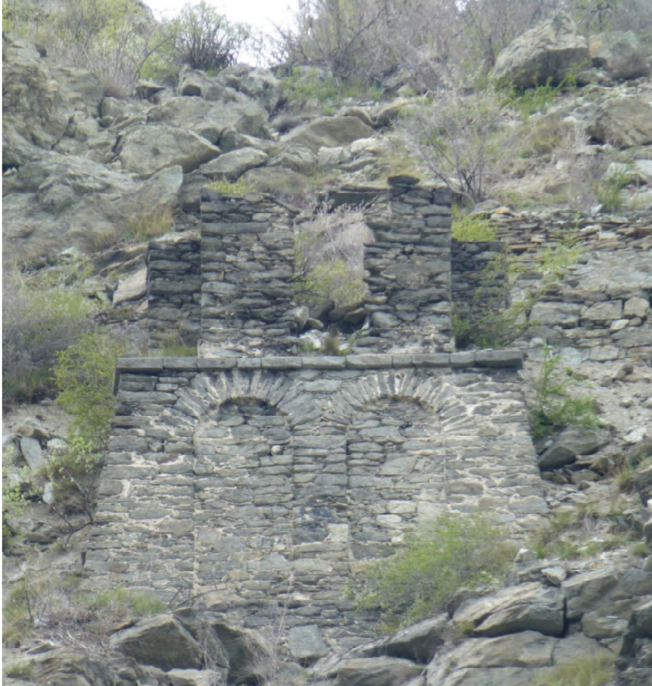
Photographie 4. Observatoire à Fourneaux en face de l'entrée de la galerie d'exploitation (E. Cottet Dumoulin, mai 2013).
