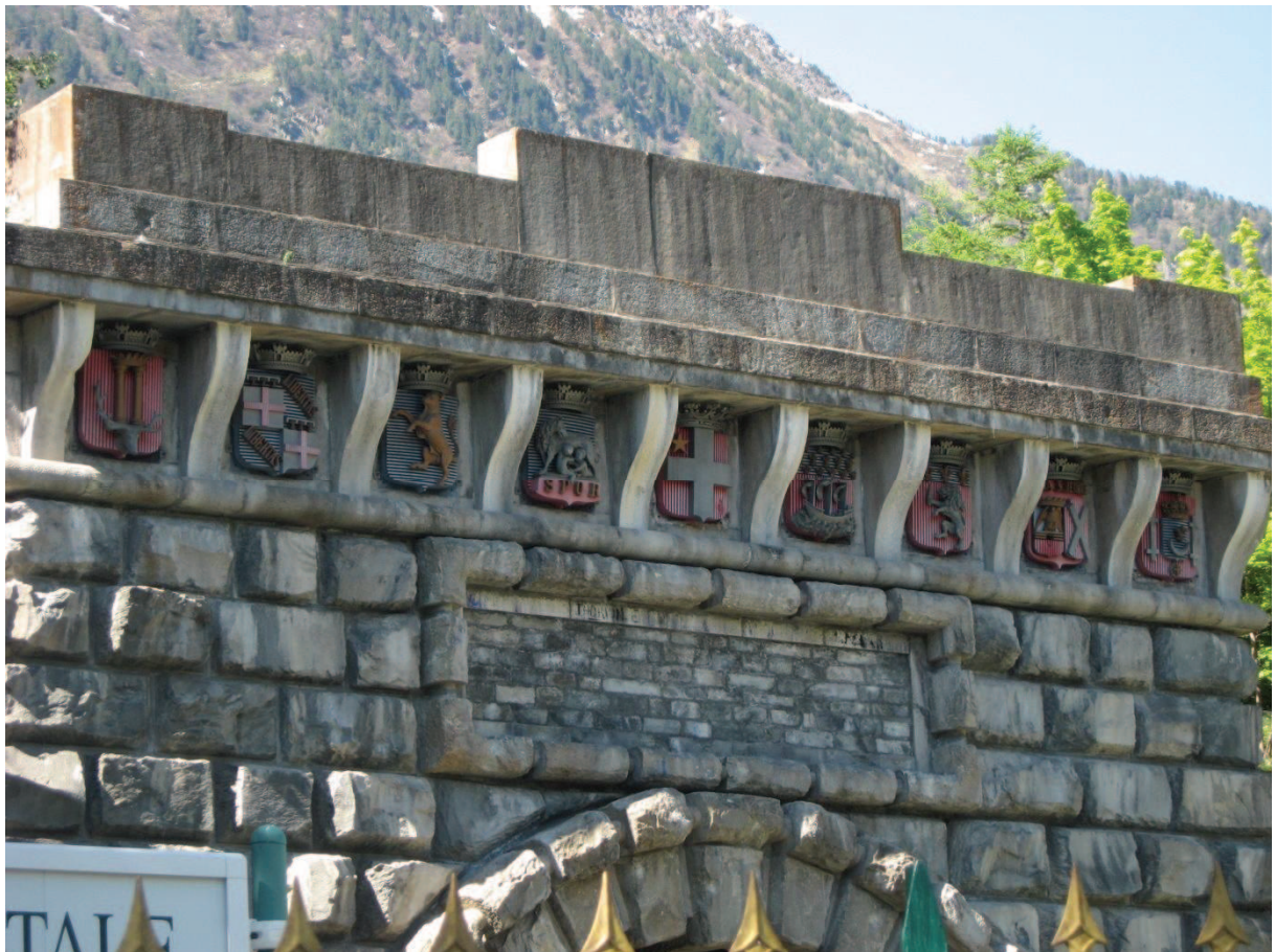
Photographie 20. Frise du portail monumental de Modane : le reflet des enjeux géopolitiques du tunnel (E. Cottet Dumoulin, juin 2011).
