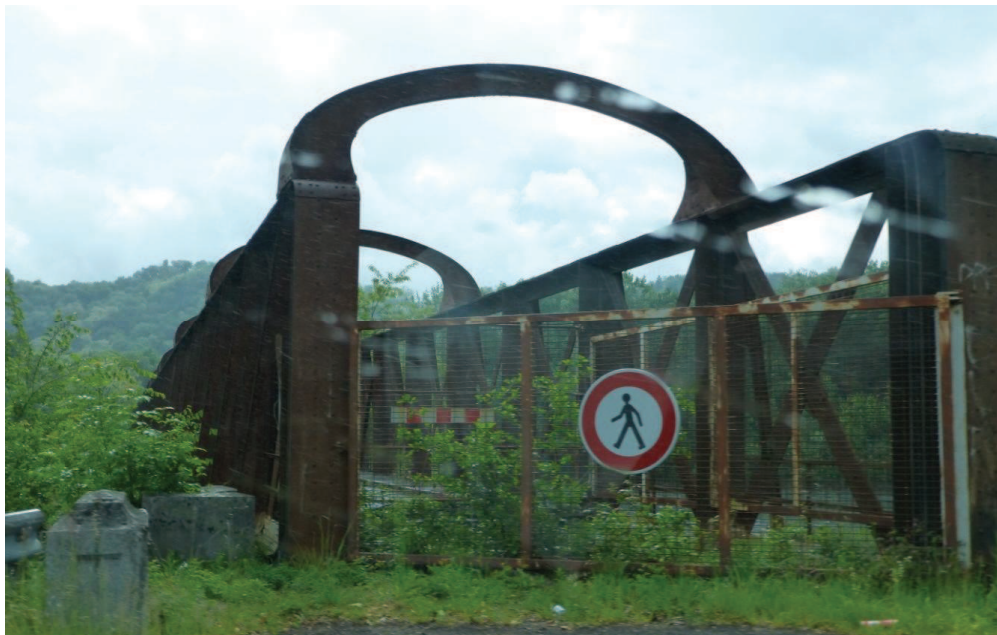
Photographie 35. Le pont-cage sur l'Isère à Cruet construit par la Compagnie Victor-Emmanuel (E. Cottet Dumoulin, mai 2013).
