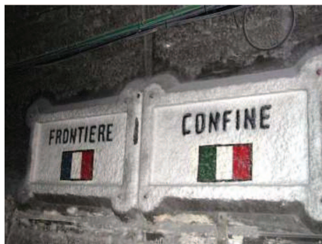
Photographies 49 a et b. Matérialisations de la frontière entre la France et l'Italie au milieu du tunnel du Mont-Cenis (Ministero delle Infrastrutture e dei trasporti).
