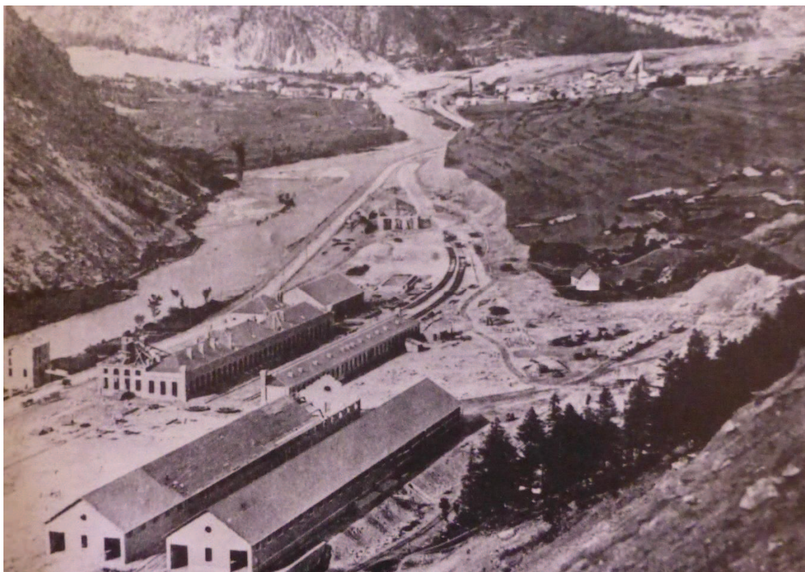
Photographie 46. Vue de la gare de Modane en construction en 1870 (R. RATEL, Le tunnel ferroviaire du Fréjus, 1857-1995 , Saint-Jean-de-Maurienne, Imp. Roux, 1997, p. 103).
