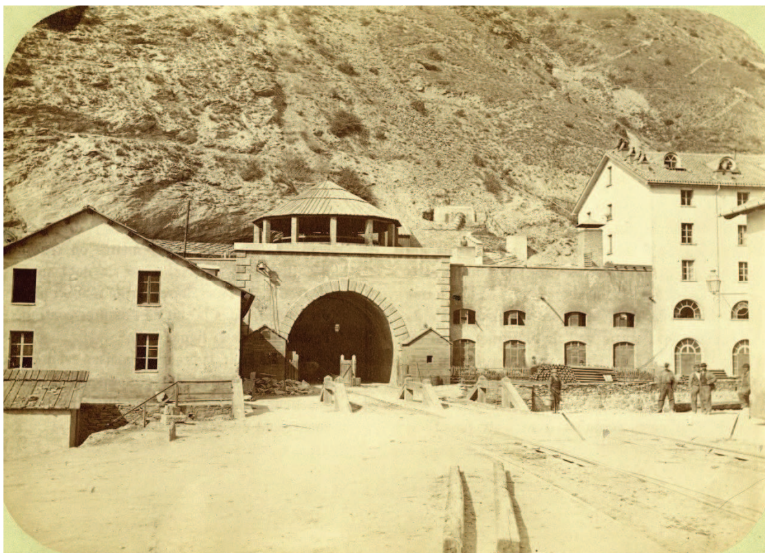
Photographie 10. Entrée de la galerie préparatoire à Bardonnèche (document conservé au Musée savoisien, Chambéry). Au-dessus du portail se trouve le toit de protection de l'aspirateur.
